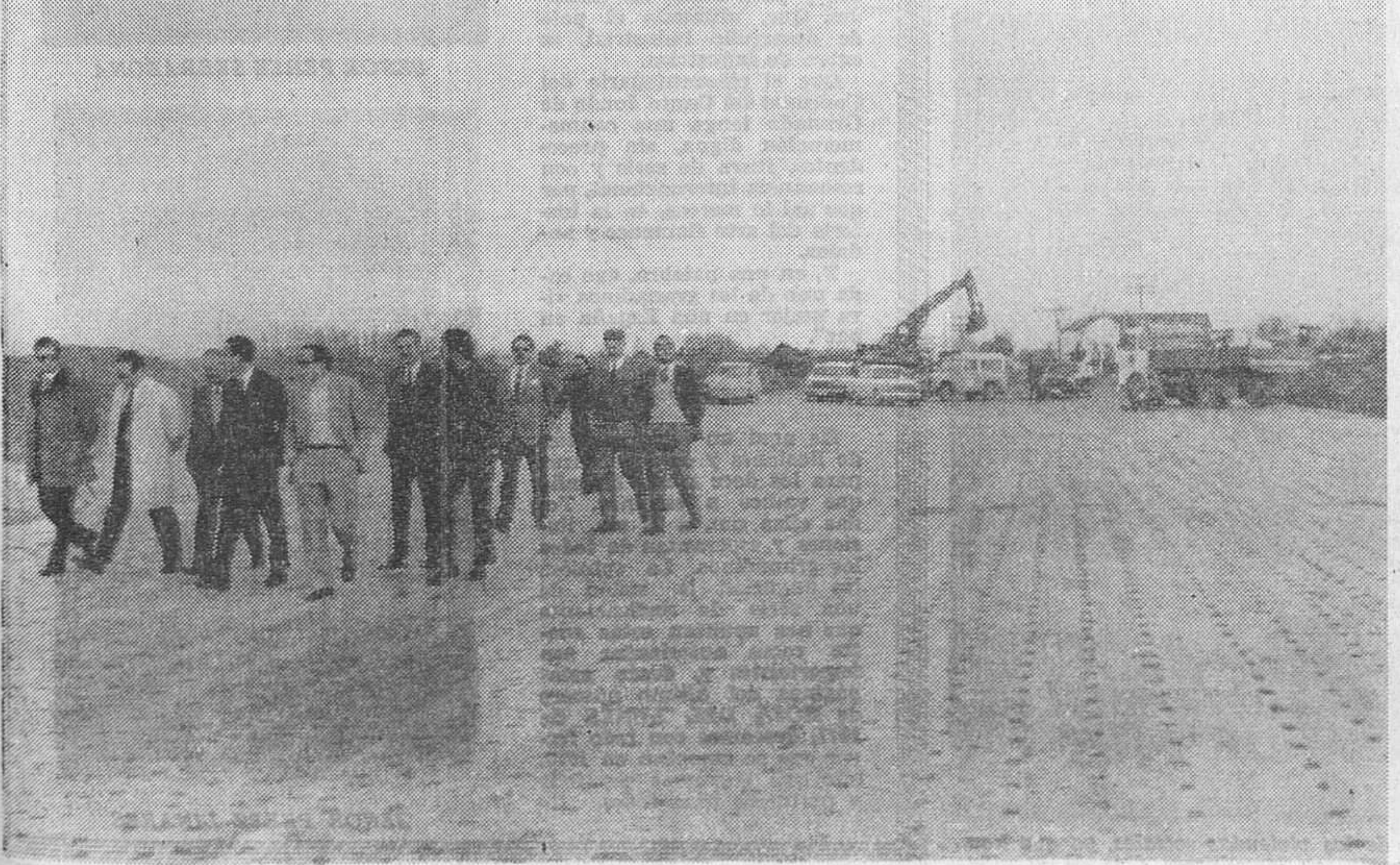
Es increíble el ritmo de las obras de construcción de la carretera al aeropuerto, con el desvío que se hará de la carretera de Málaga en esa zona. En la fotografía se puede apreciar ya el trazado de la nueva vía
