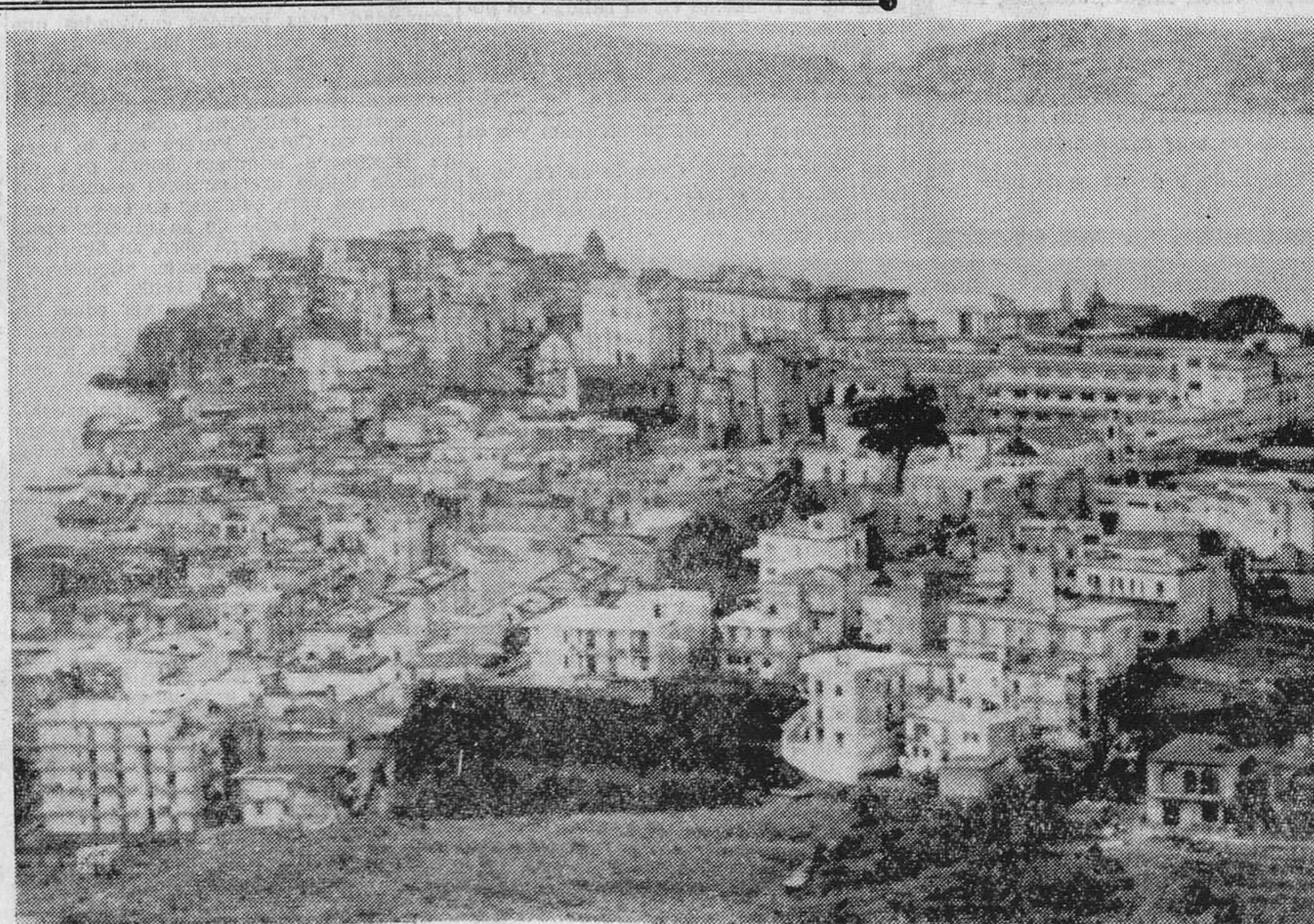
Esta es una parte de la ciudad, la vieja, precisamente la más afectada, de Pozzuoli (Italia), donde los habitantes están siendo evacuados ante el peligro que encierra el extraño fenómeno del movimiento ascensional de la tierra con sorprendentes repercusiones en el mar, cuyas aguas se tiñende grises a temperaturas tan elevadas que hierven los peces.
