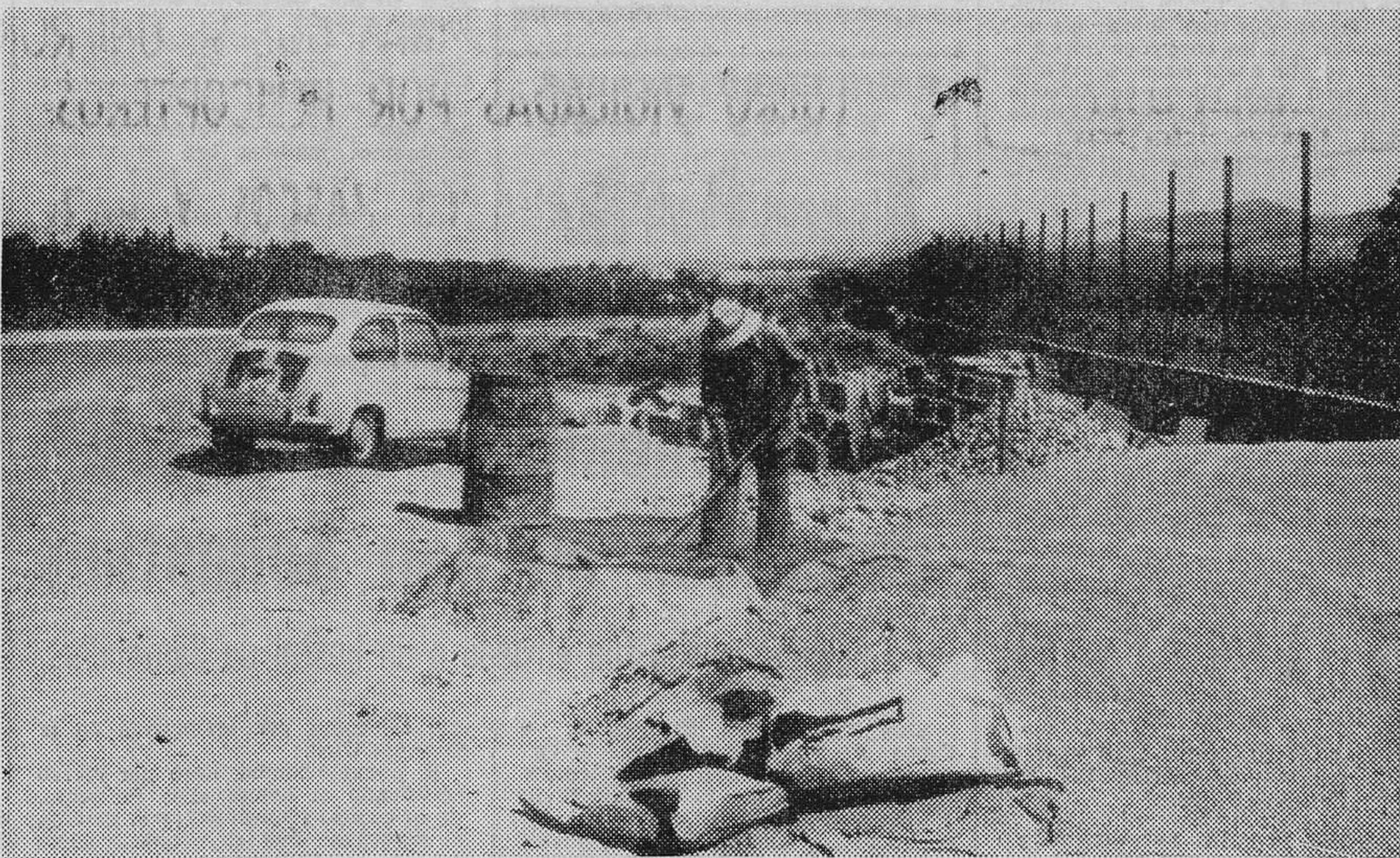
Aunque con pocos obreros, las obras continúan en el trabajo de la vía de comunicación entre Granada y La Zubia.
