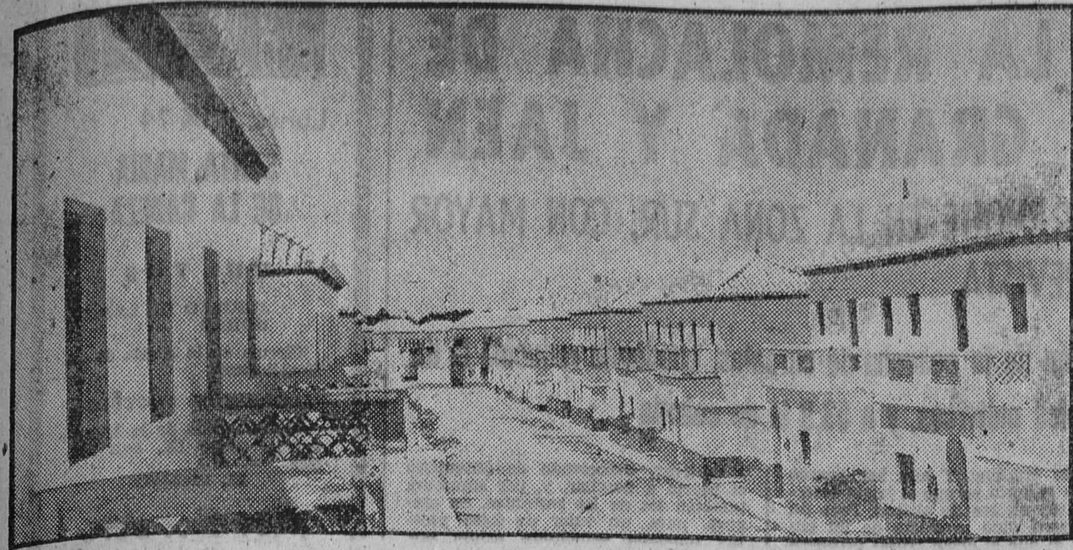
Del Zaidin antiguo, mejor dicho, de las primeras edificaciones a las actuales, media un abismo. La foto de Archivo recoge la plaza de Federico Mayo que, como puede verse, difiere mucho de las torres alzadas posteriormente y que dan a la barriada carácter de ciudad.
