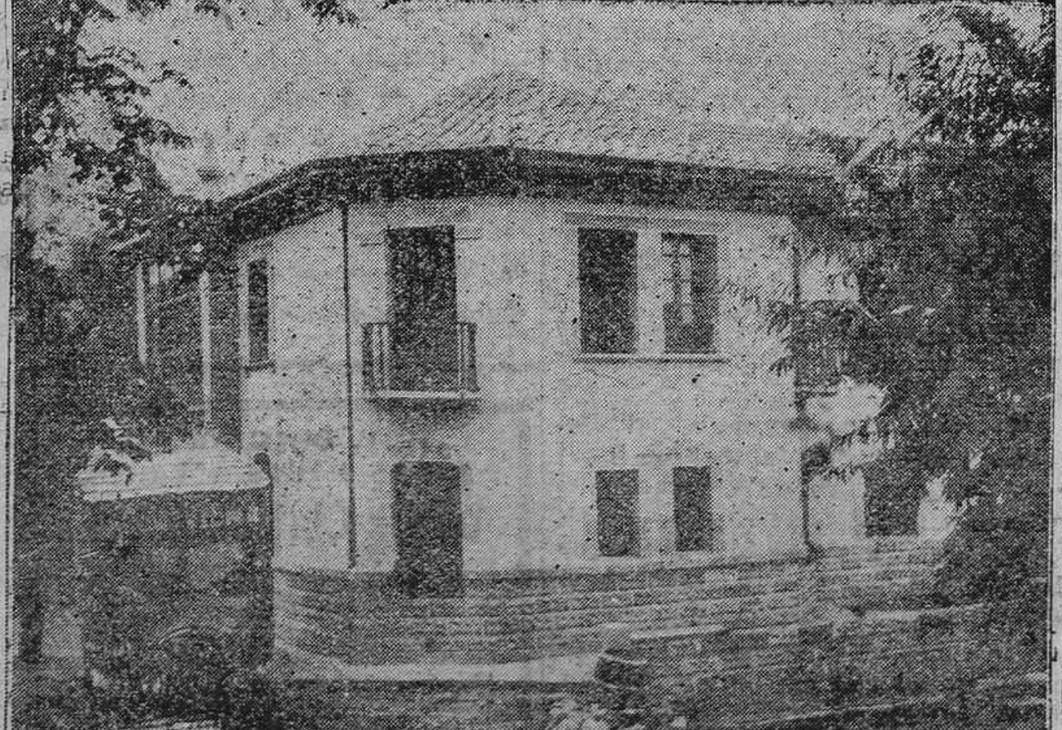
SOTO DE RIBERA. —Bonito edificio recientemente construido para D. Laureano Lobato, prestigioso miembro de la colonia americana cuyo amueblado realizó la Casa Viena de Oviedo, con su refinado gusto.
