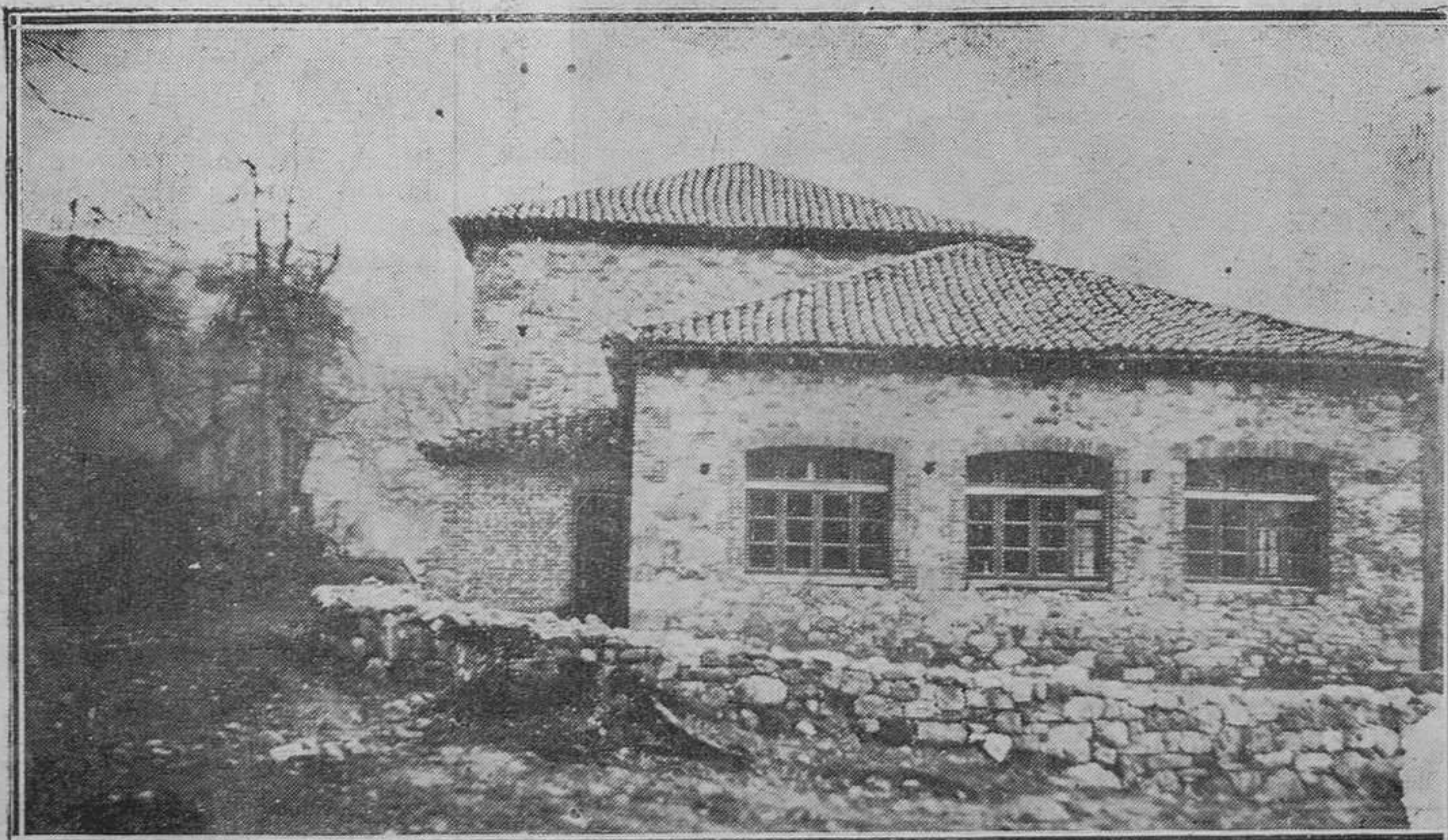
RIOSECO-SOBRESCOPIO. — Fachada lateral izquierda del edificio destinado a grupo escolar.
