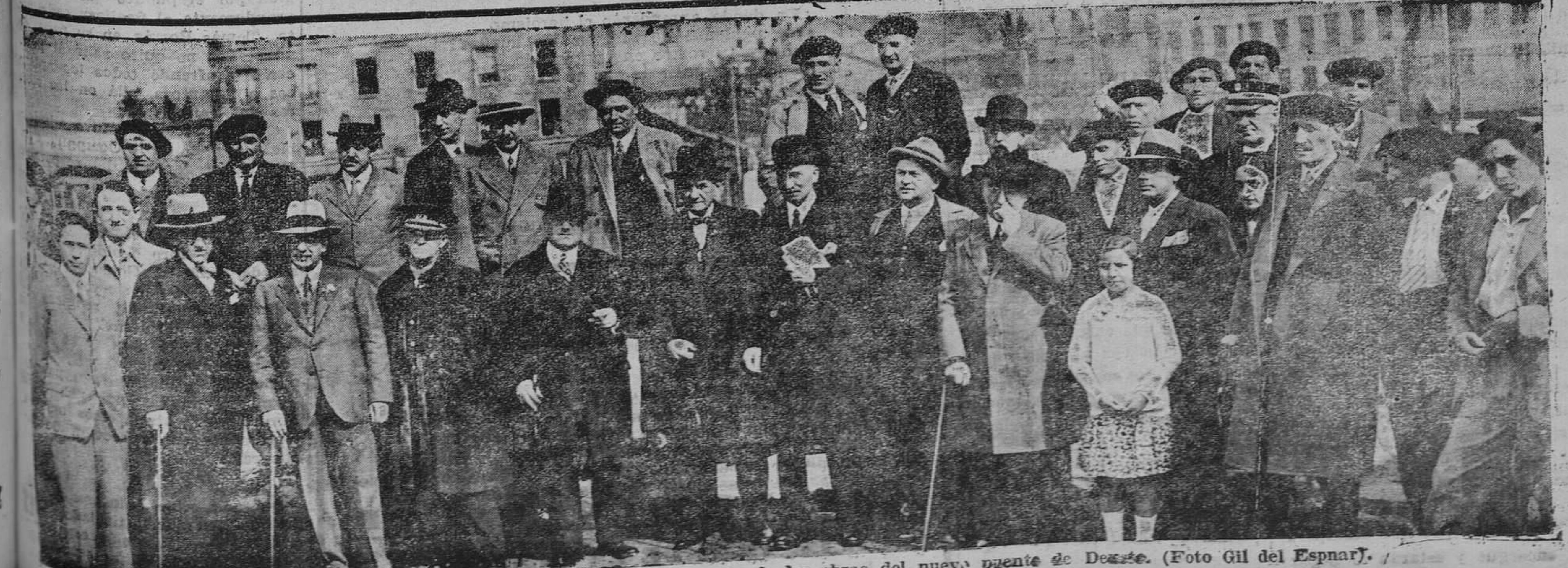
Las autoridades de Bilbao que asistieron a la inauguración de las obras del nuevo puente de Deusto. (Foto Gil del Espñar).
