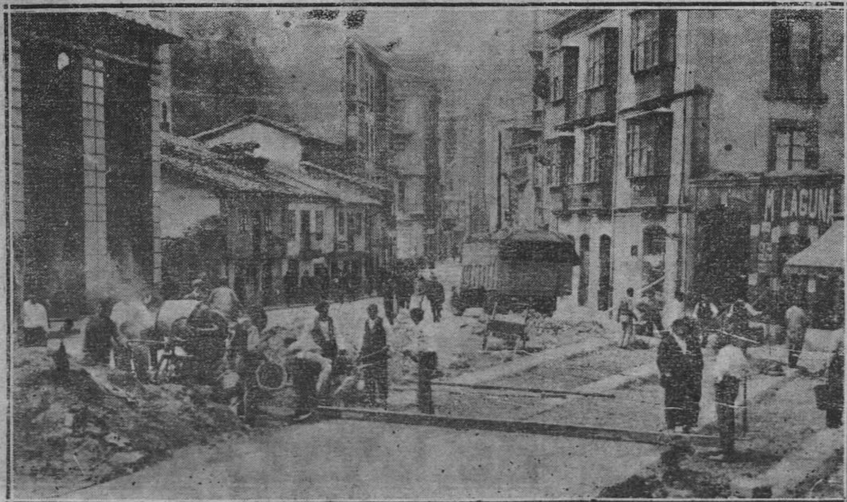
OVIEDO.—Comienzo de las obras de pavimentado, del Paseo de San Juan. (Foto MEX)
