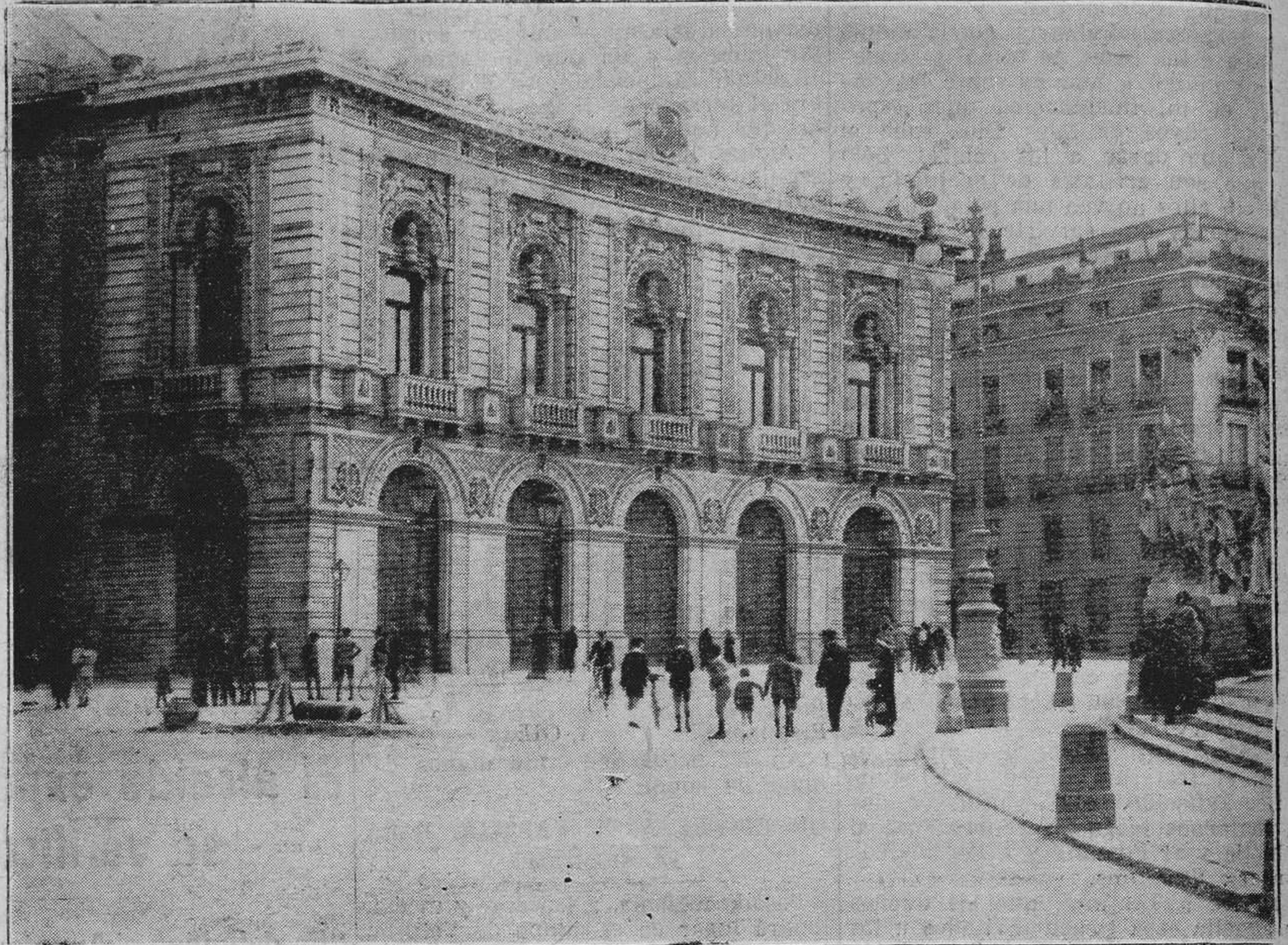
MADRID.-Fachada principal del teatro Real, que se dice está amenazado de hundimiento.
