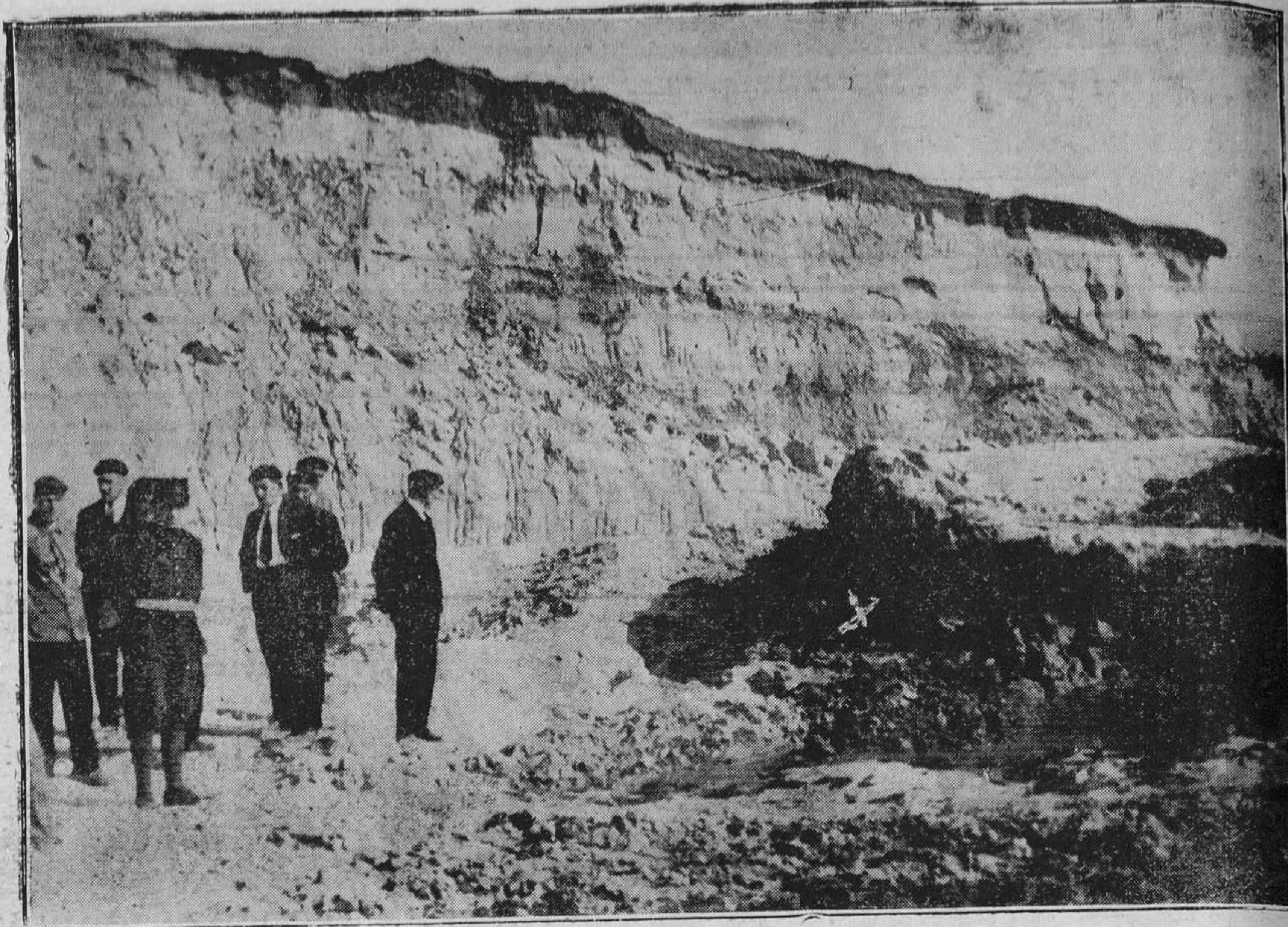
DEL ACCIDENTE DE AYER. (X). Lugar en donde quedó enterrado Constantino Braña, en los Areneros de San Esteban de las Cruces, a causa de un desprendimiento de arena. (Foto Bueita)
