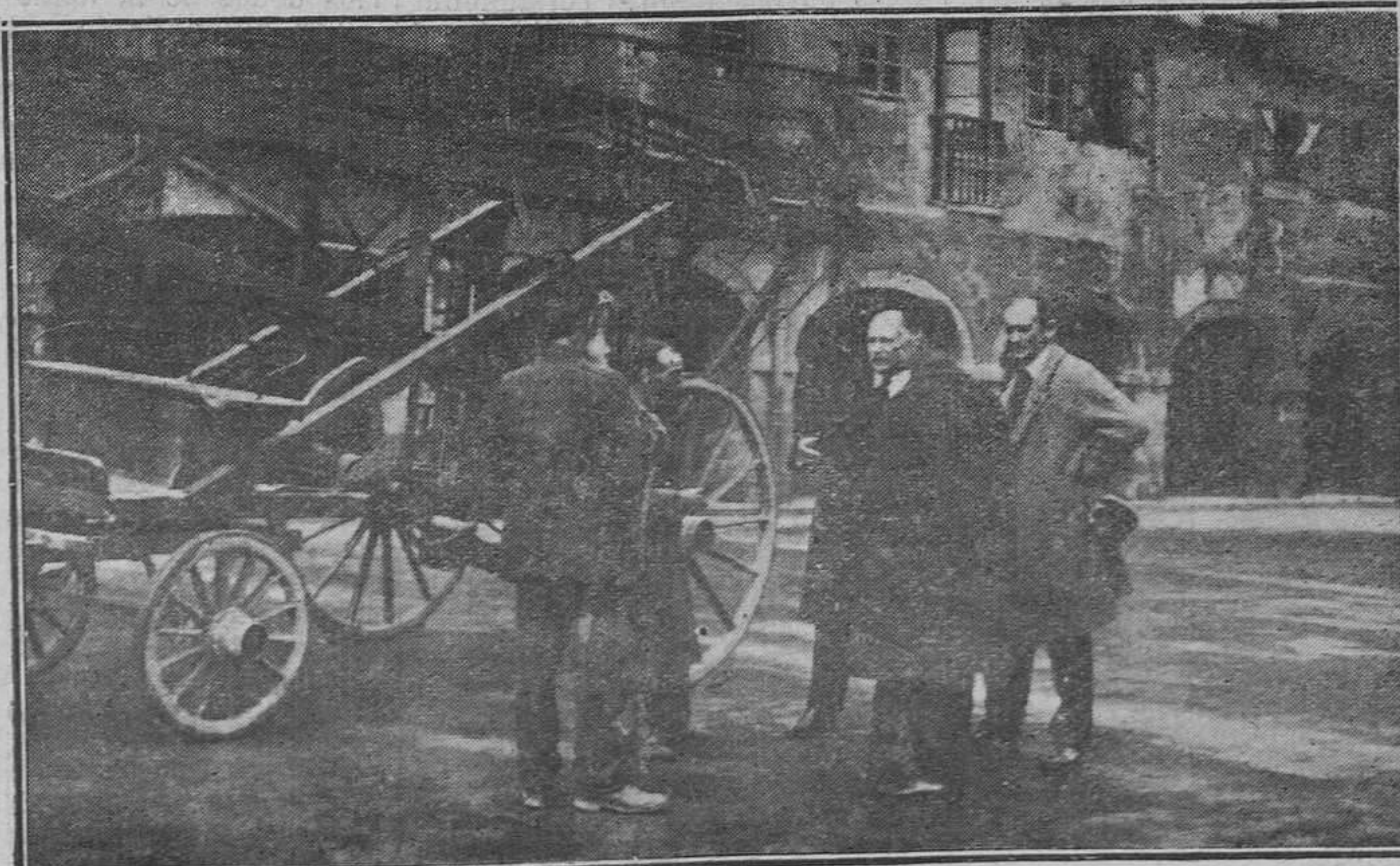
OVIEDO.—Las Bodas de plata de la Adoración Nocturna.—El Ingeniero Jefe de Obras públicas, y el señor Christensen, dando órdenes al personal que trabaja en la Catedral. (Foto Mena)
