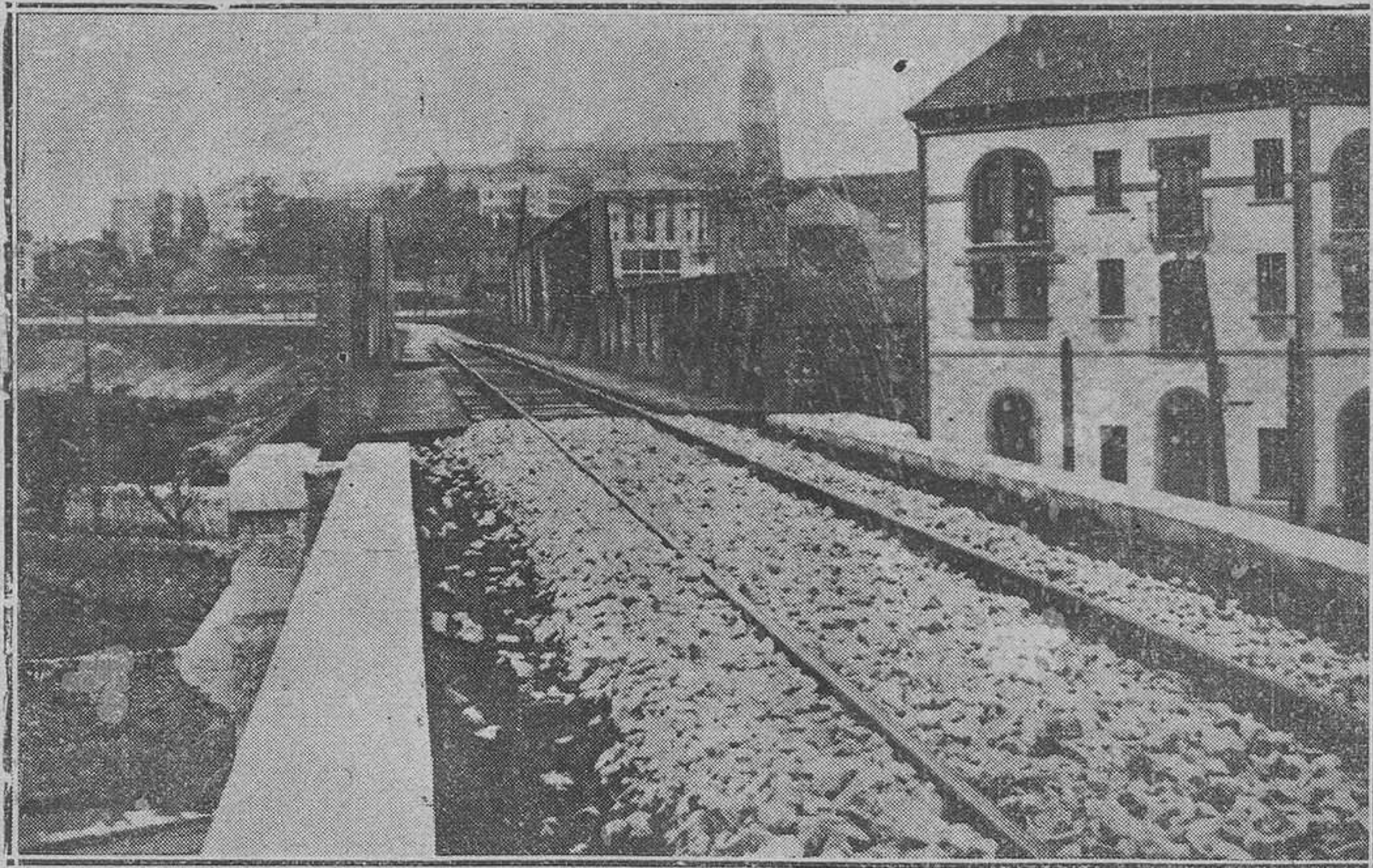
OVIEDO.-Una vista de uno de los puentes de la línea de enlace de los ferrocarriles de Económicos y Vascos Asturianos, inaugurada días pasados. (foto Mena)
