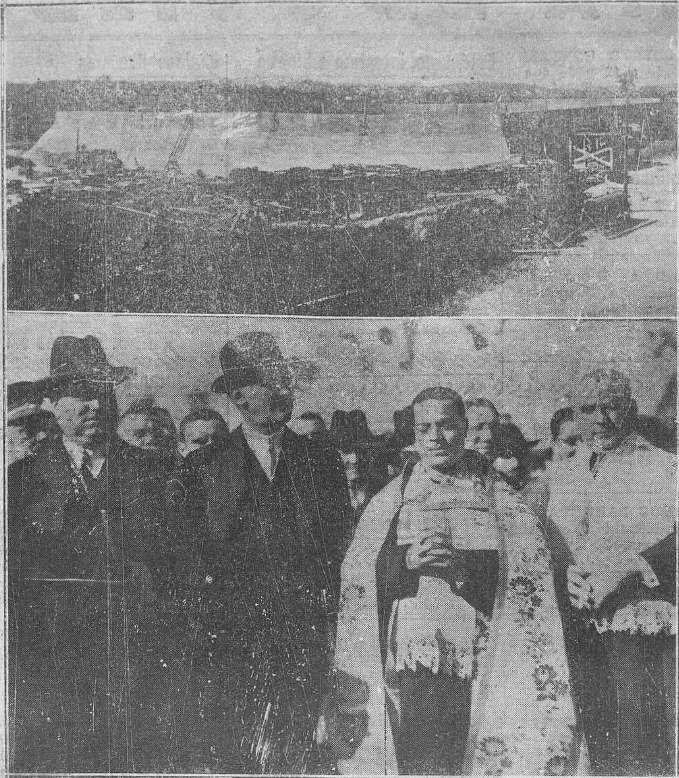
GIJÓN.-Arriba: El nuevo depósito de aguas, capaz para 100.000 metros cúbicos.-Abajo: Las autoridades locales y provinciales en el solemne acto de la bendición. (Foto Klark)
