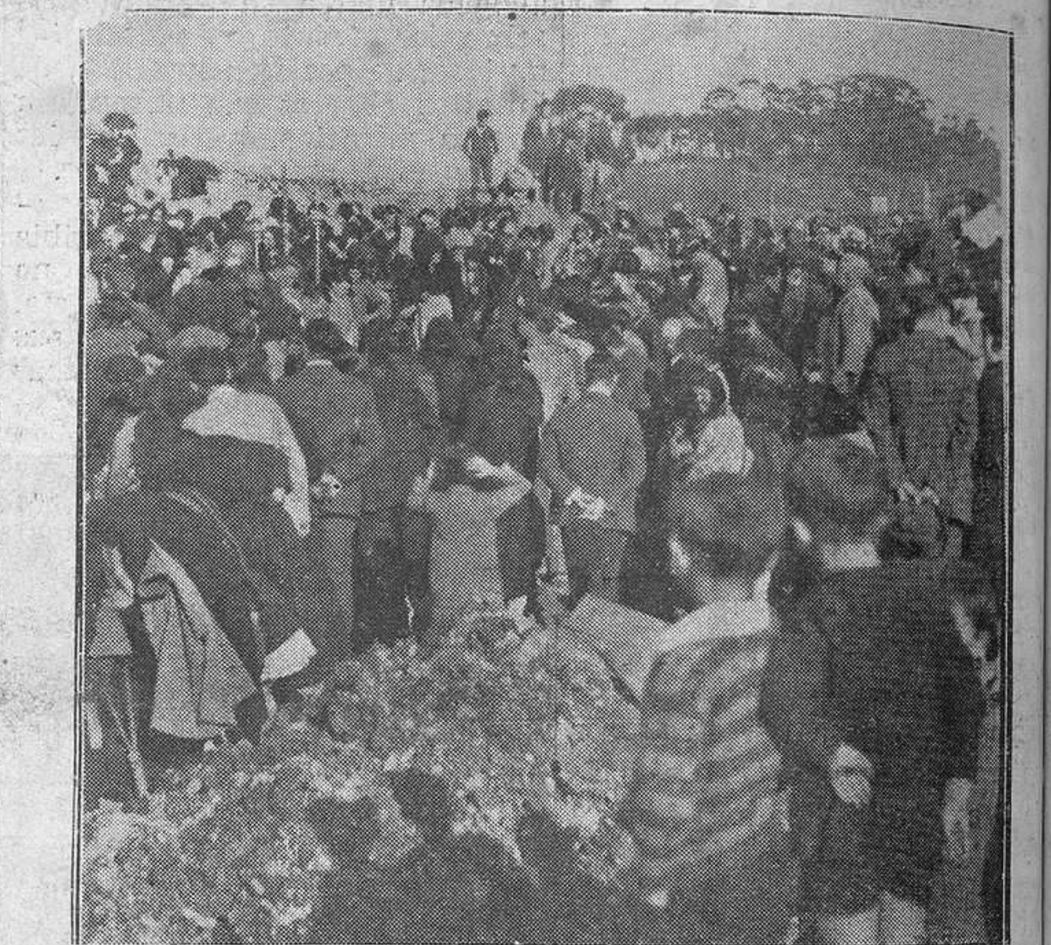
COLUNGA.-Colocación de la primera piedra del nuevo Hospital-asilo.
