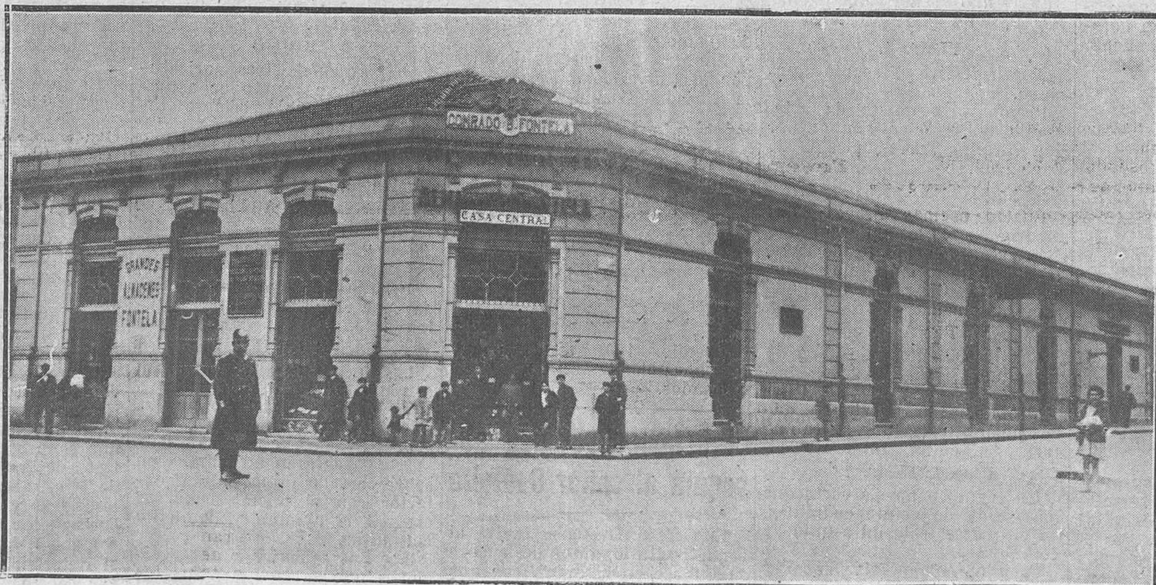
CASA CENTRAL FRENTE A LA IGLESIA DE SAN JUAN
