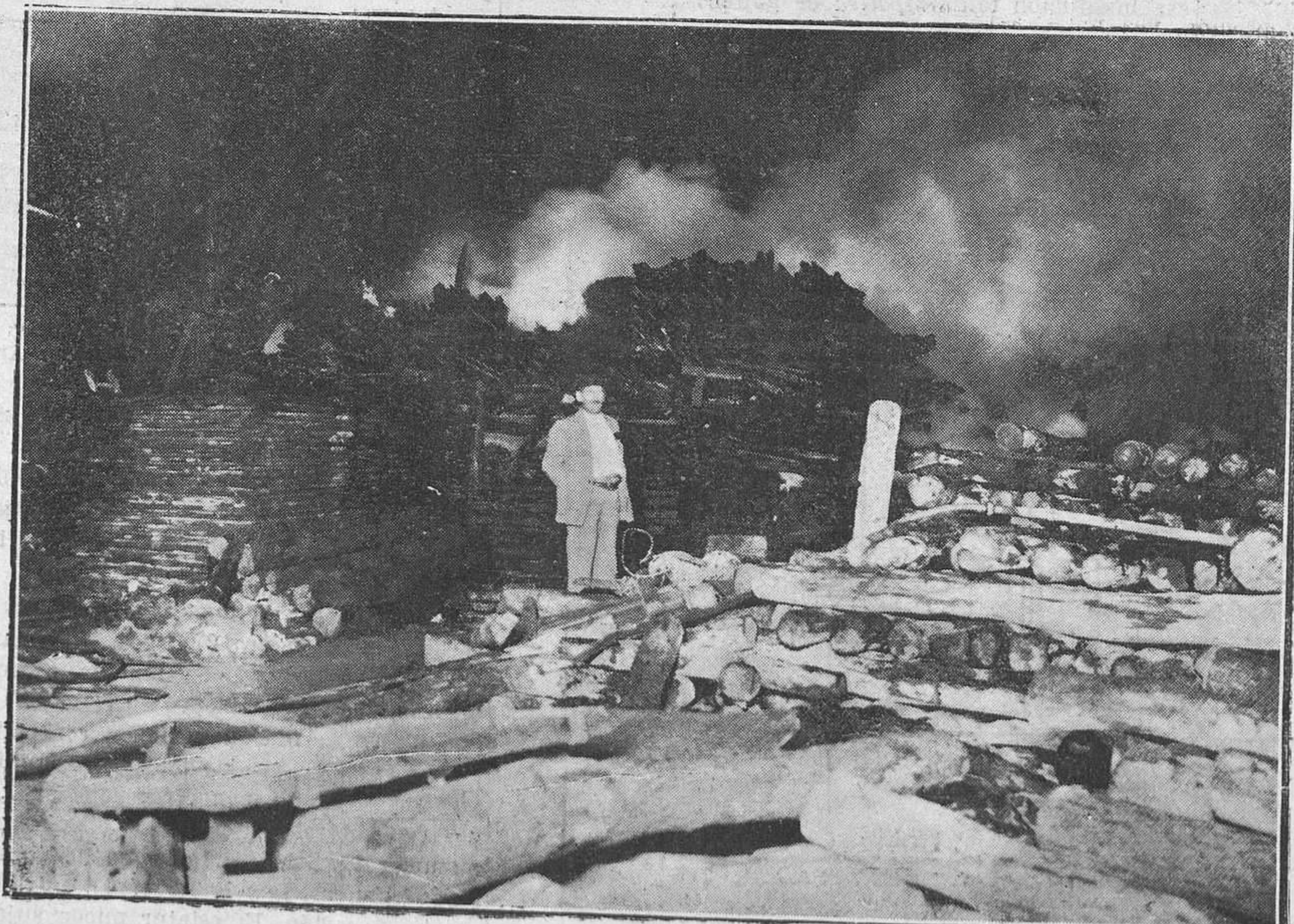
MADRID.-Los bomberos trabajando en la extinción del incendio de los talleres del “Metropolitano”.
