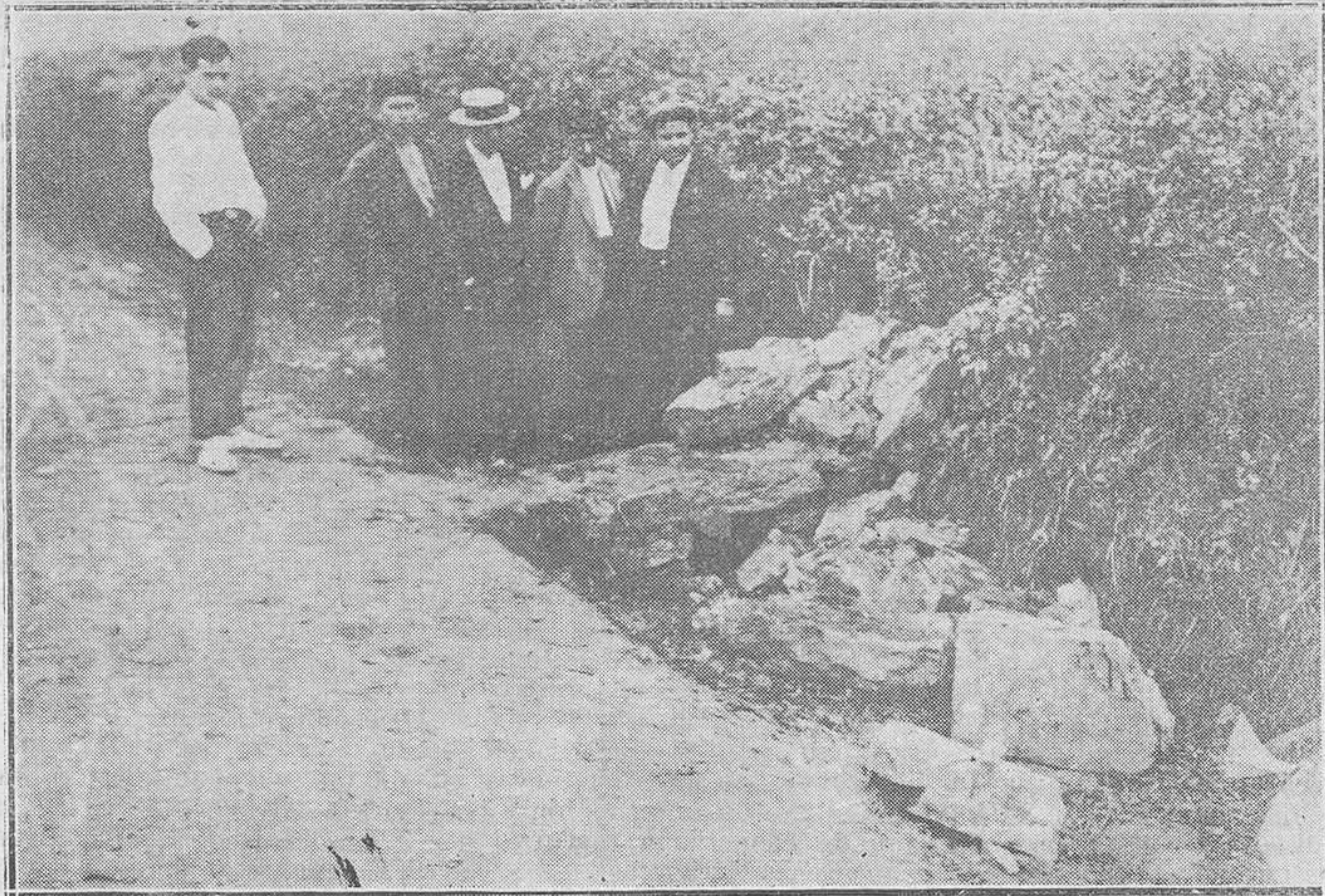
SARIEGO.-Puentecillo contra el que chocó la camioneta que volcó, ocasionando una verdadera catástrofe (Foto MENA)
