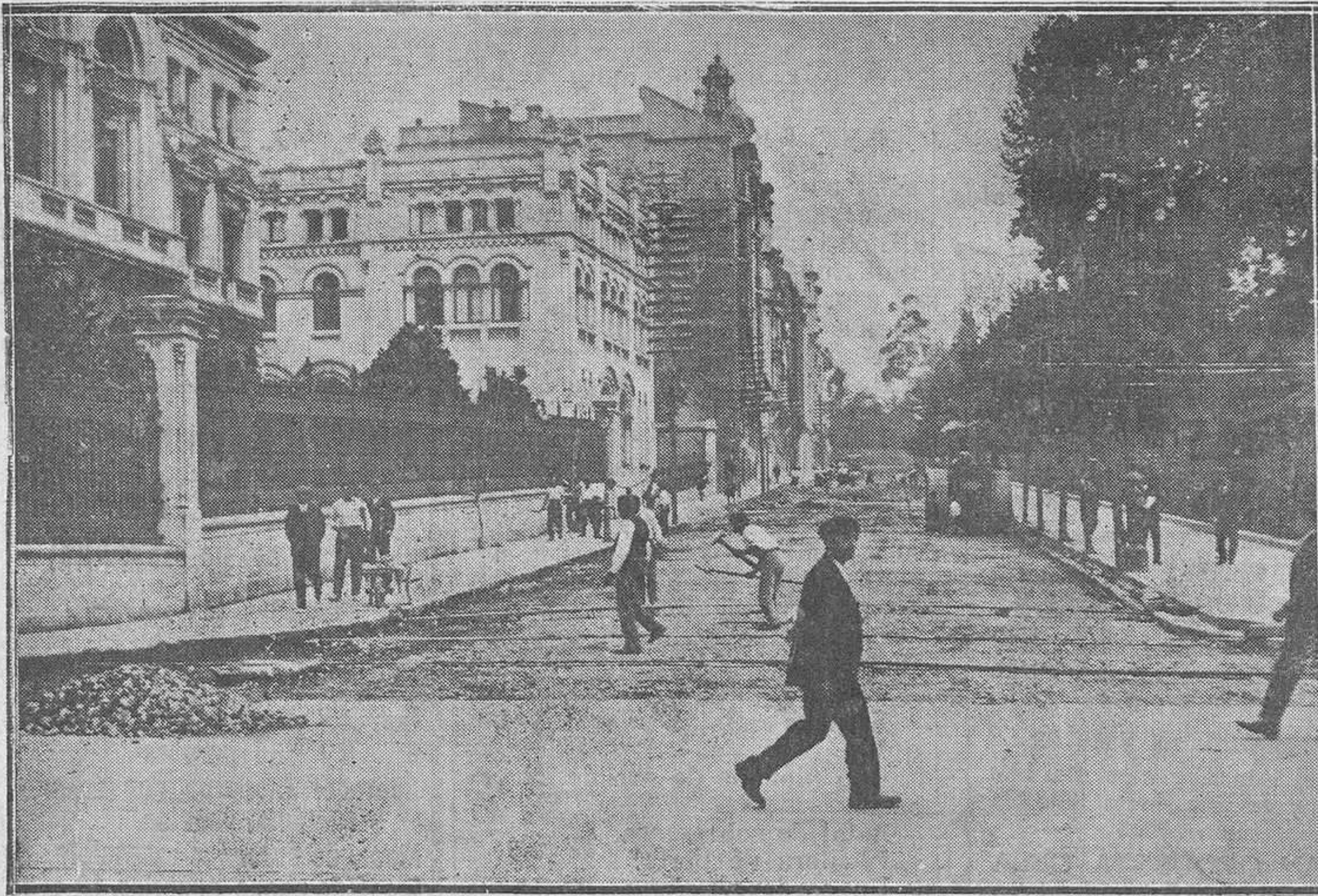
OVIEDO.—Un aspecto de las obras de pavimentación de la calle del Marqués de Santa Cruz. MENA
