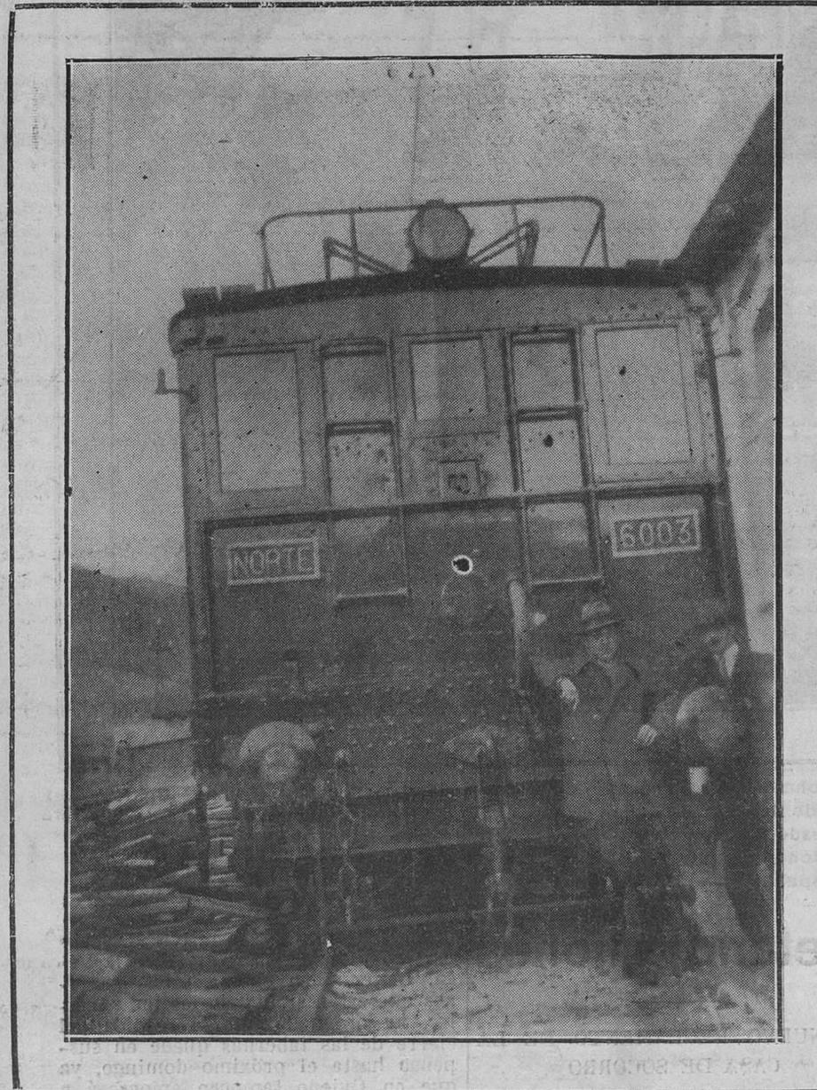
ELECTRIFICACIÓN DE LA RAMPA DEL PAJARES.—Una de las nuevas locomotoras, vista de frente.
