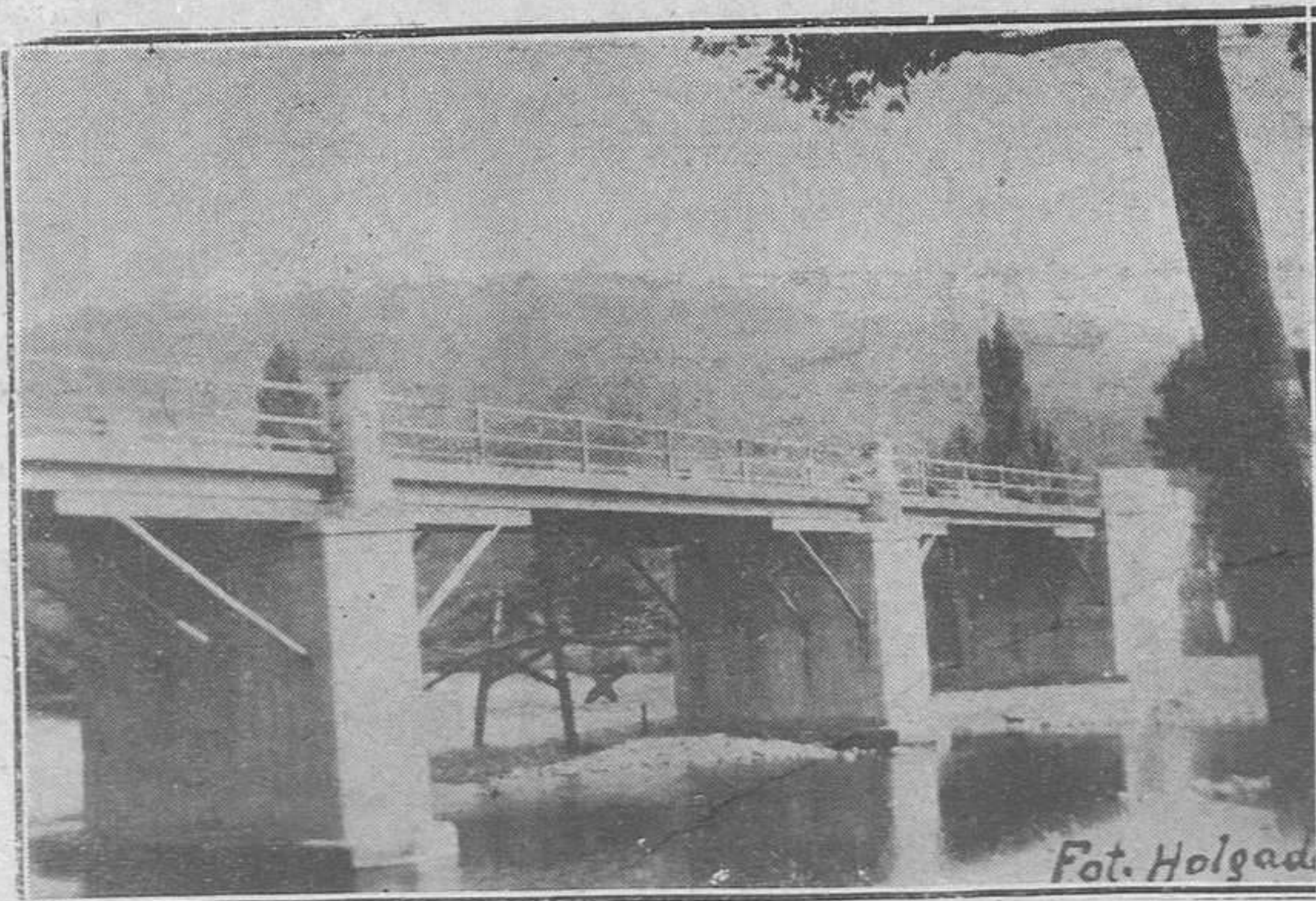
LAVIANA: PUENTE NUEVO DE LA CHALANA.-Aquí se ve el puente antiguo (X), y la esmerada construcción del moderno.
