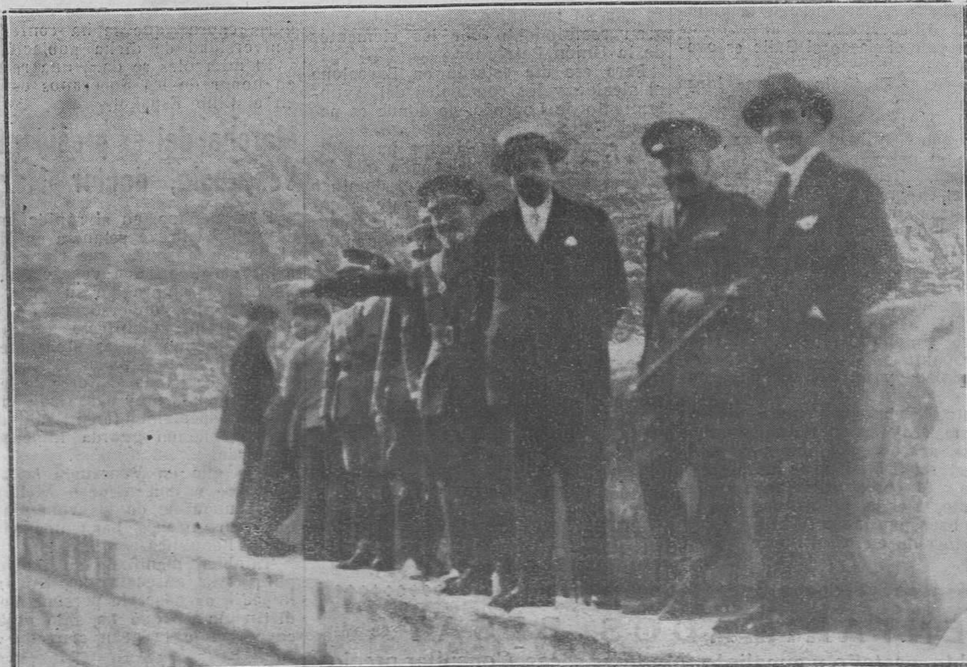
GIJÓN.-El ministro de la Guerra, en el muro del dique Morfe del Museo, con el gobernador civil, el alcalde y el coronel del Tarragona.
