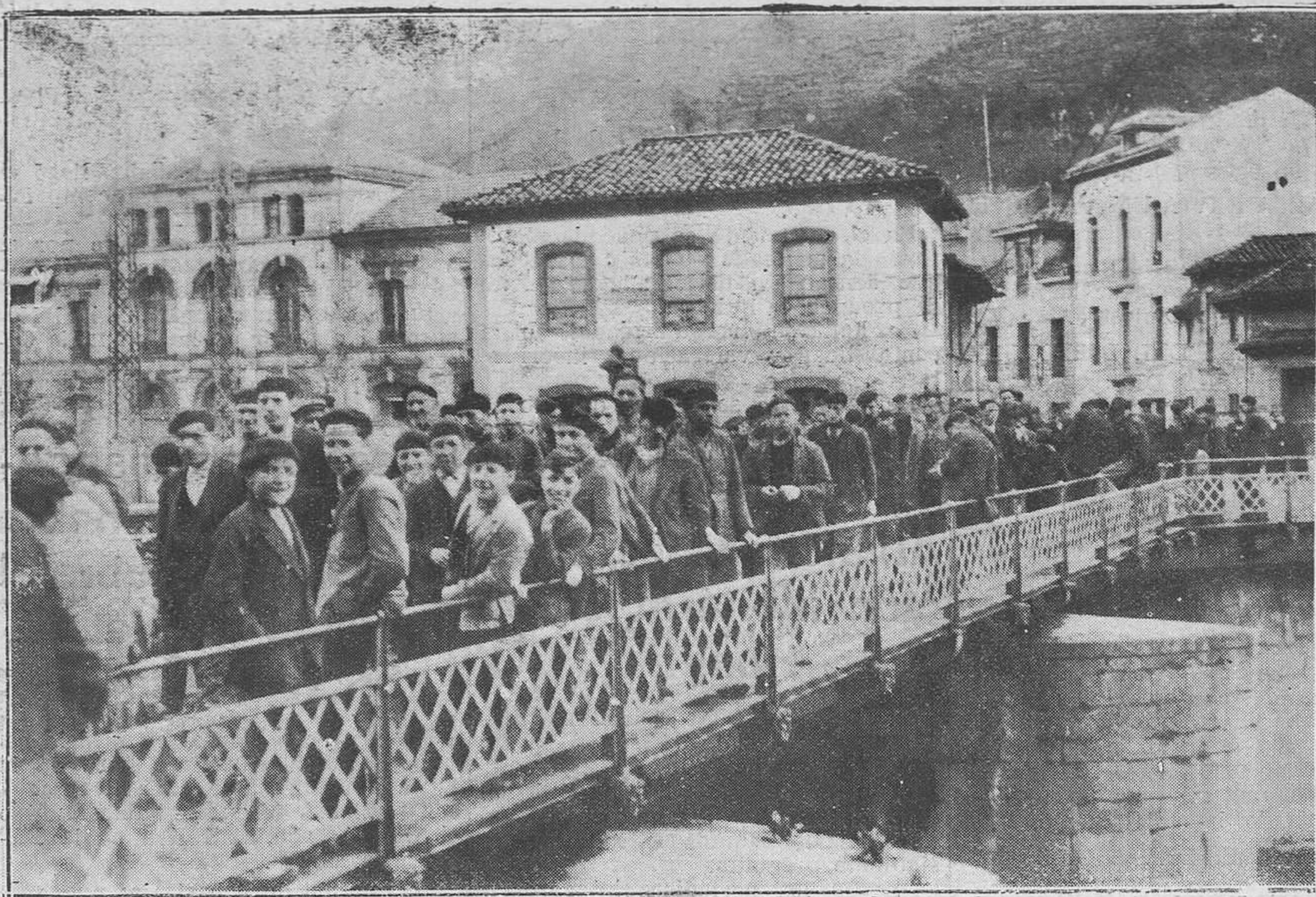
LA VIDA EN TRUBIA.-A la hora de entrada al trabajo, el puente de hierro amenaza hundirse bajo el peso de los obreros... (Foto Buelta)
