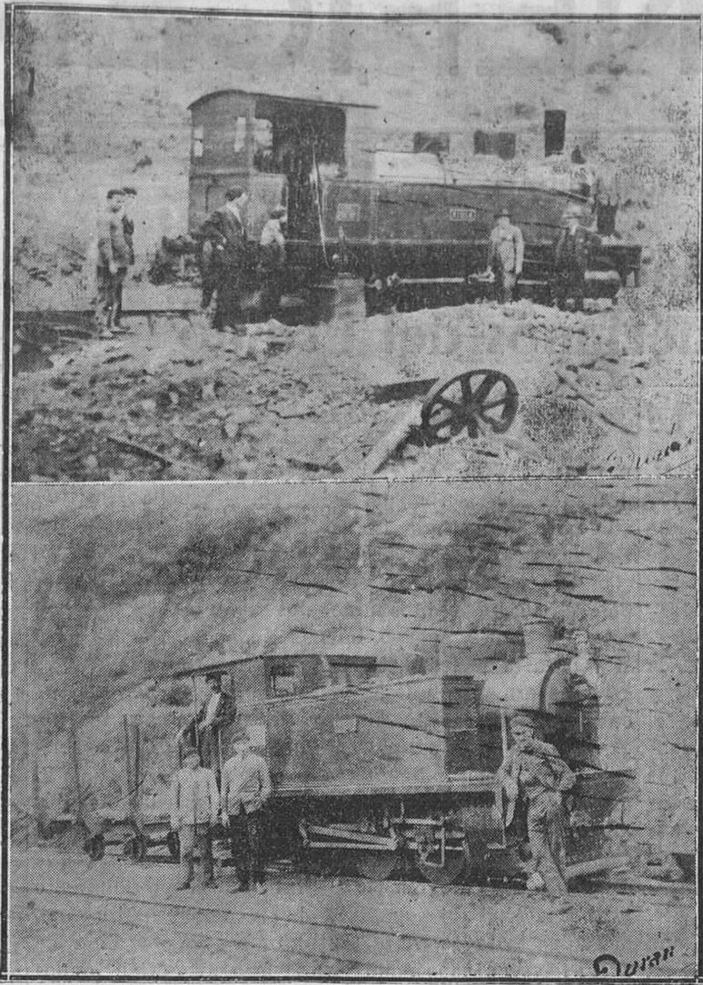
LA PEREDA (ABLAÑA): HULLERAS DE RIOSA.—(1) Nueva máquina "Riosa", que transporta el carbón de La Pereda a Ablaña. (2) Nueva máquina "Loreda", que funciona entre la Pereda y La Foz. Este nuevo material de tracción que en el coto minero de "Hulleras de Riosa" ha introducido la Empresa, ha causado muy buena impresión y está siendo muy favorablemente comentado. (Foto Durán)
