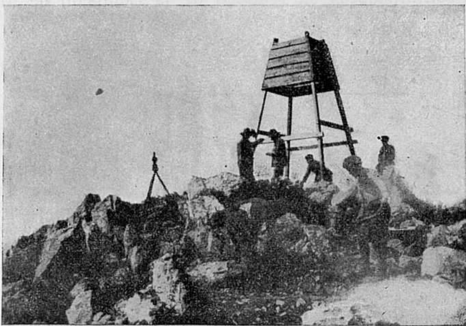
Marruecos. —Emplazamiento de una mira geodésica.
