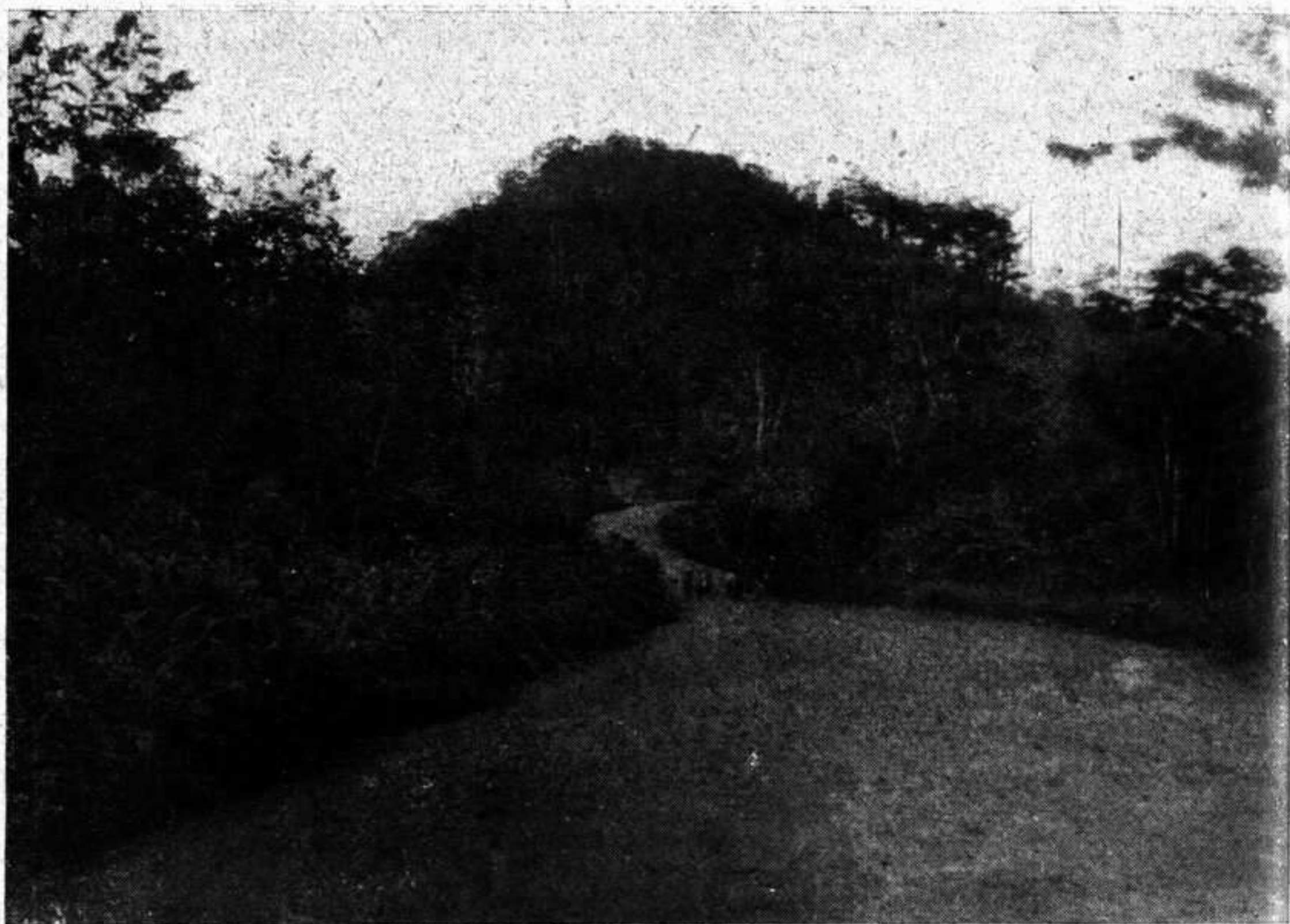
Carretera en construcción de Evinayong a Akurennam.
