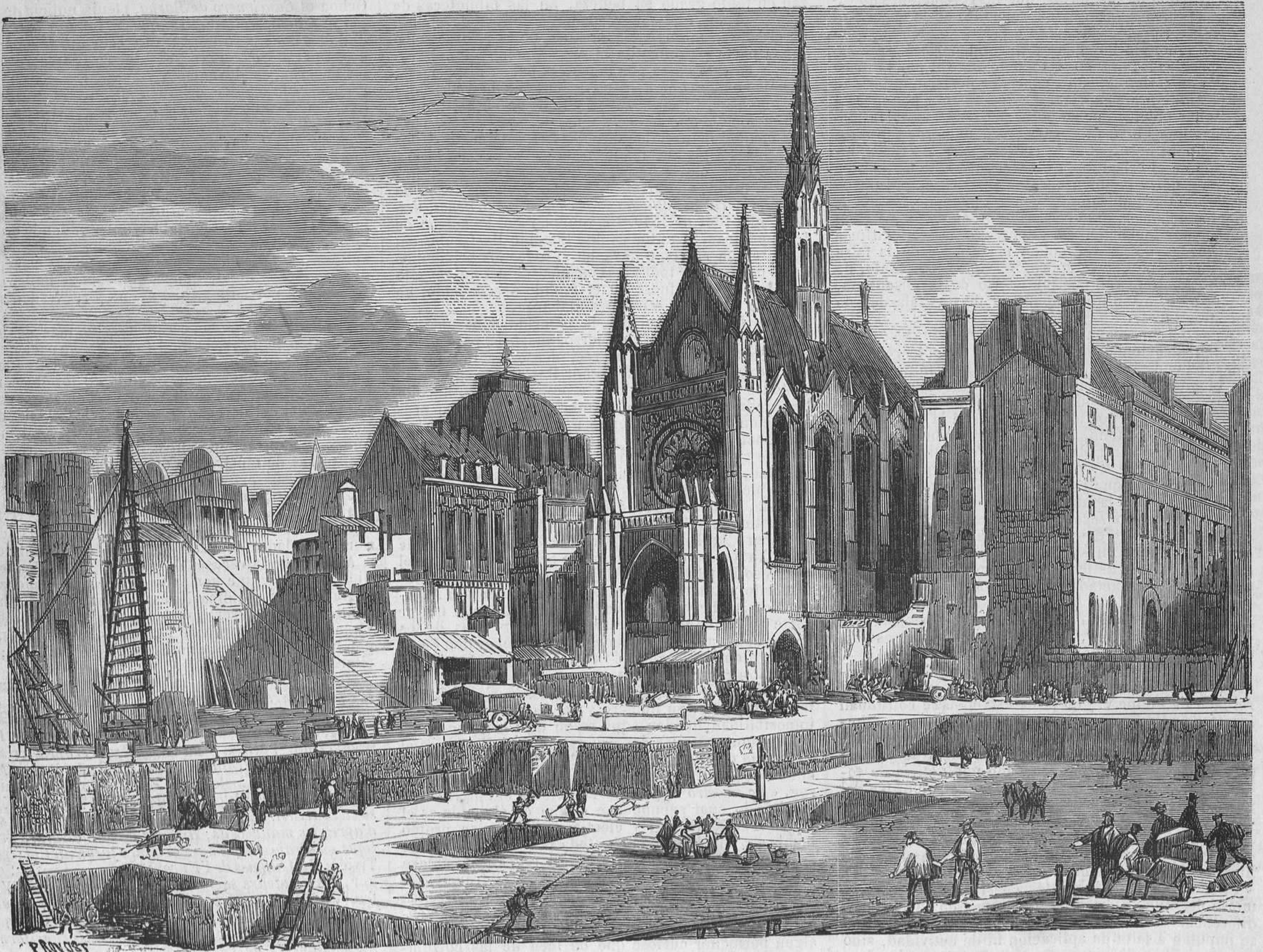
PARIS. — Obras en las inmediaciones de la Santa Capilla para la reconstrucción de la Prefectura de Policía.
