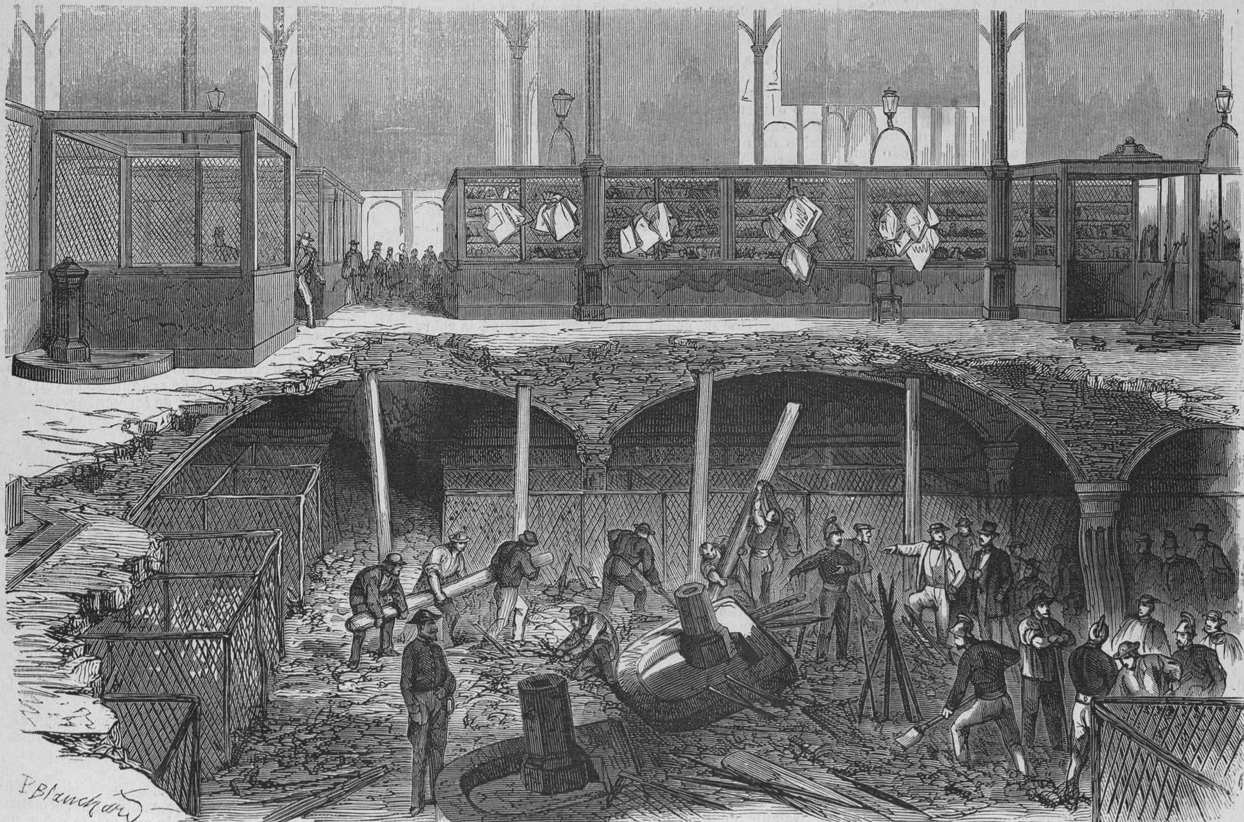
PARIS. — Incendio en los mercados. — Aspecto de los sótanos despues del hundimiento de las bóvedas
