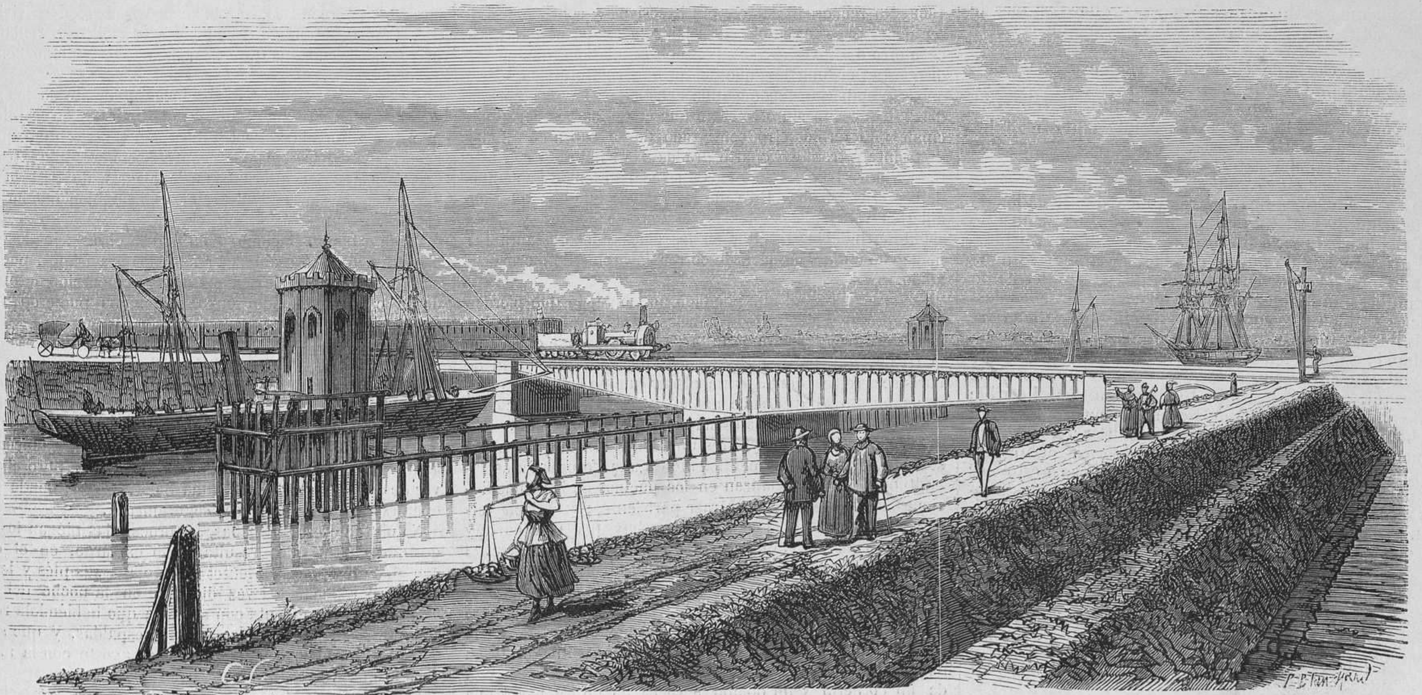
Bélgica. — El canal de Zuyd-Pereland. Puente giratorio que da paso al ferrocarril.
