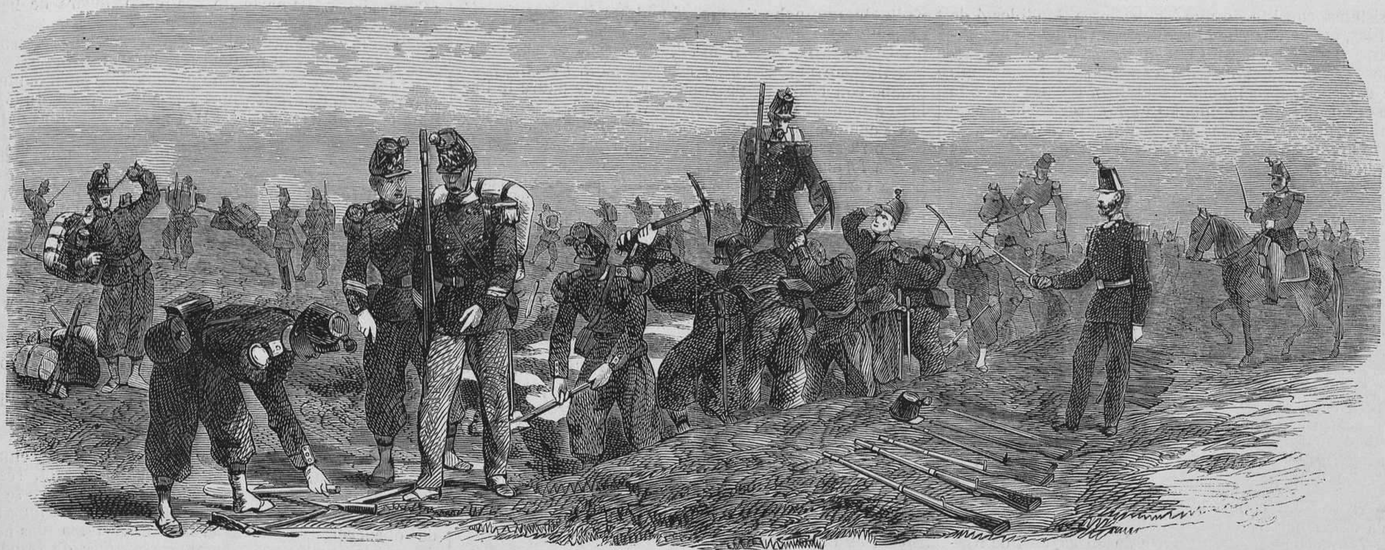
CAMPAMENTO DE CHALONS. — Abertura de una trinchera-abrigo.
