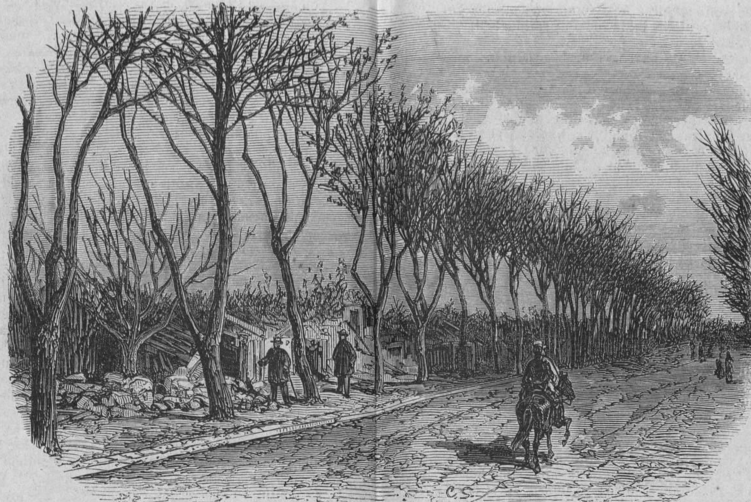
EFECTOS DEL TERREMOTO EN ARGELIA.
