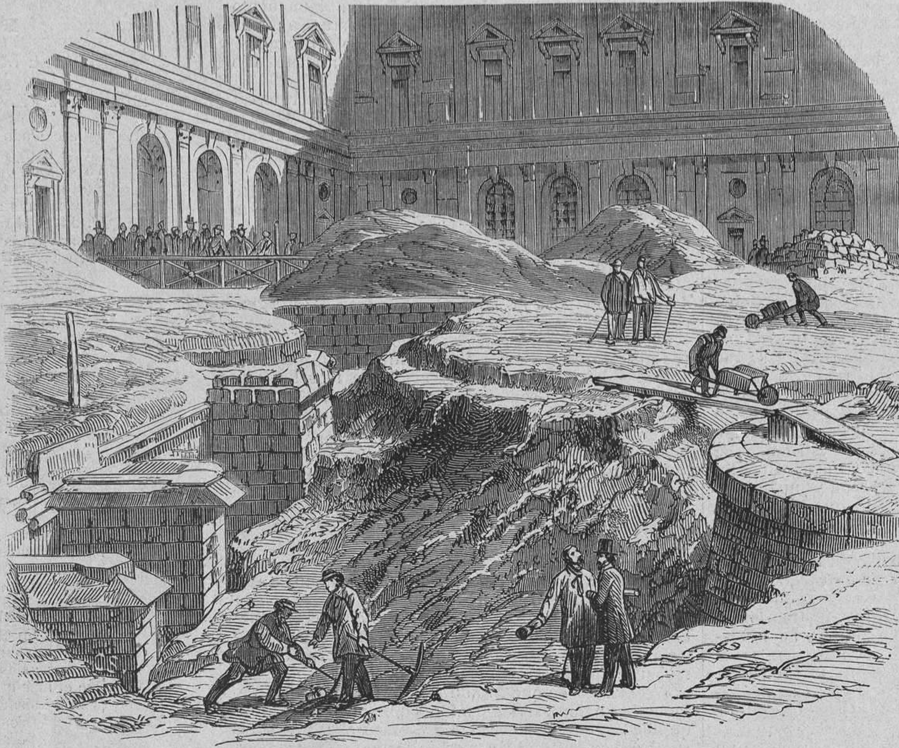
Excavaciones en el patio del Louvre. — Restos de las construcciones antiguas.
