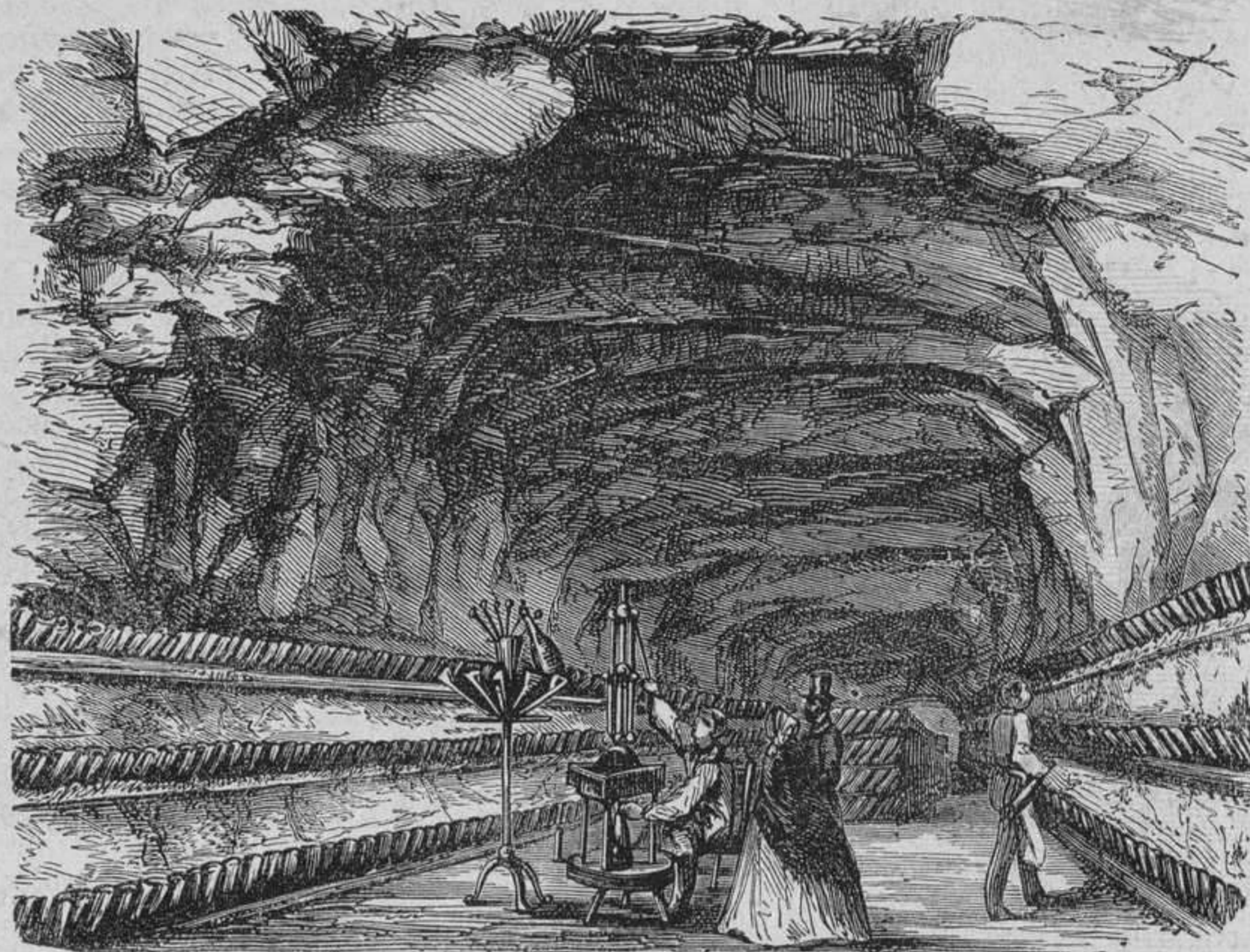
Vista de las quince bóvedas de las bodegas.
