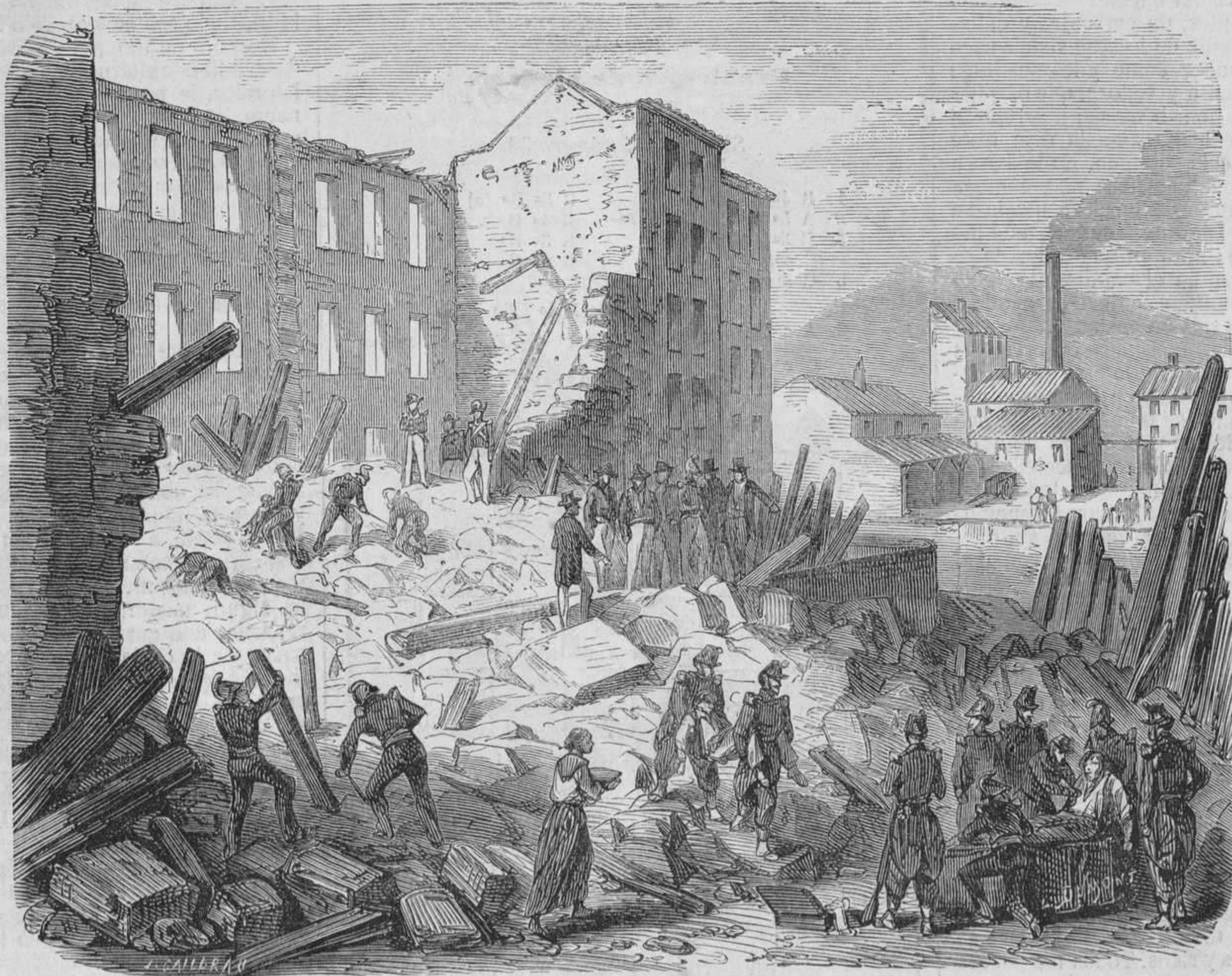
Hundimiento de una casa en Marsella.
