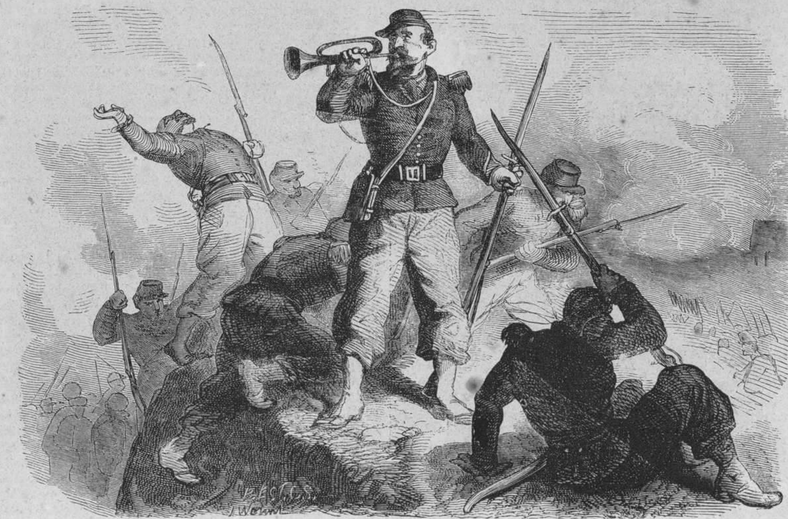
El corneta Roblet sobre los muros de Guadalupe.
