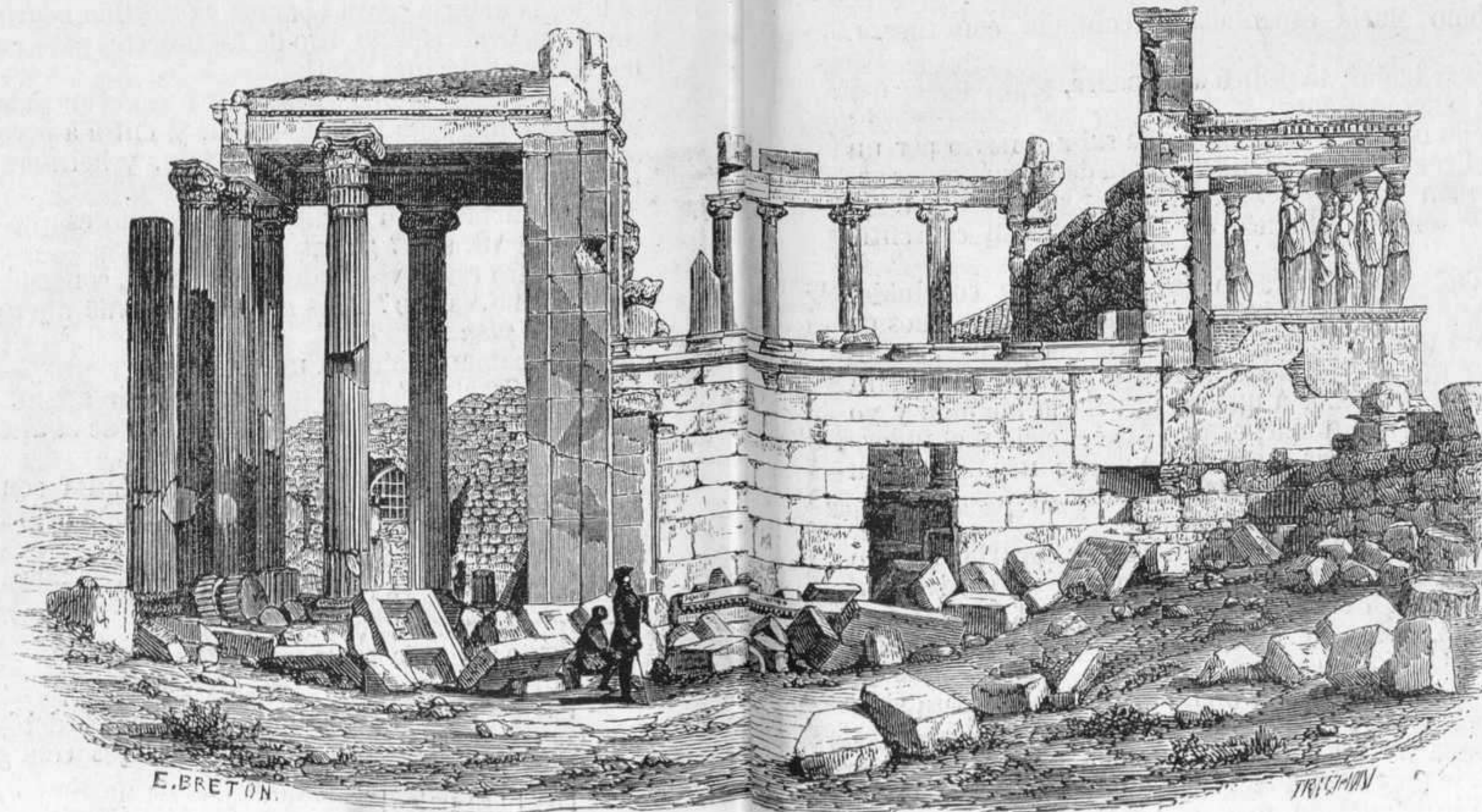
FACHADA OCCIDENTAL DEL ERECTEION.
