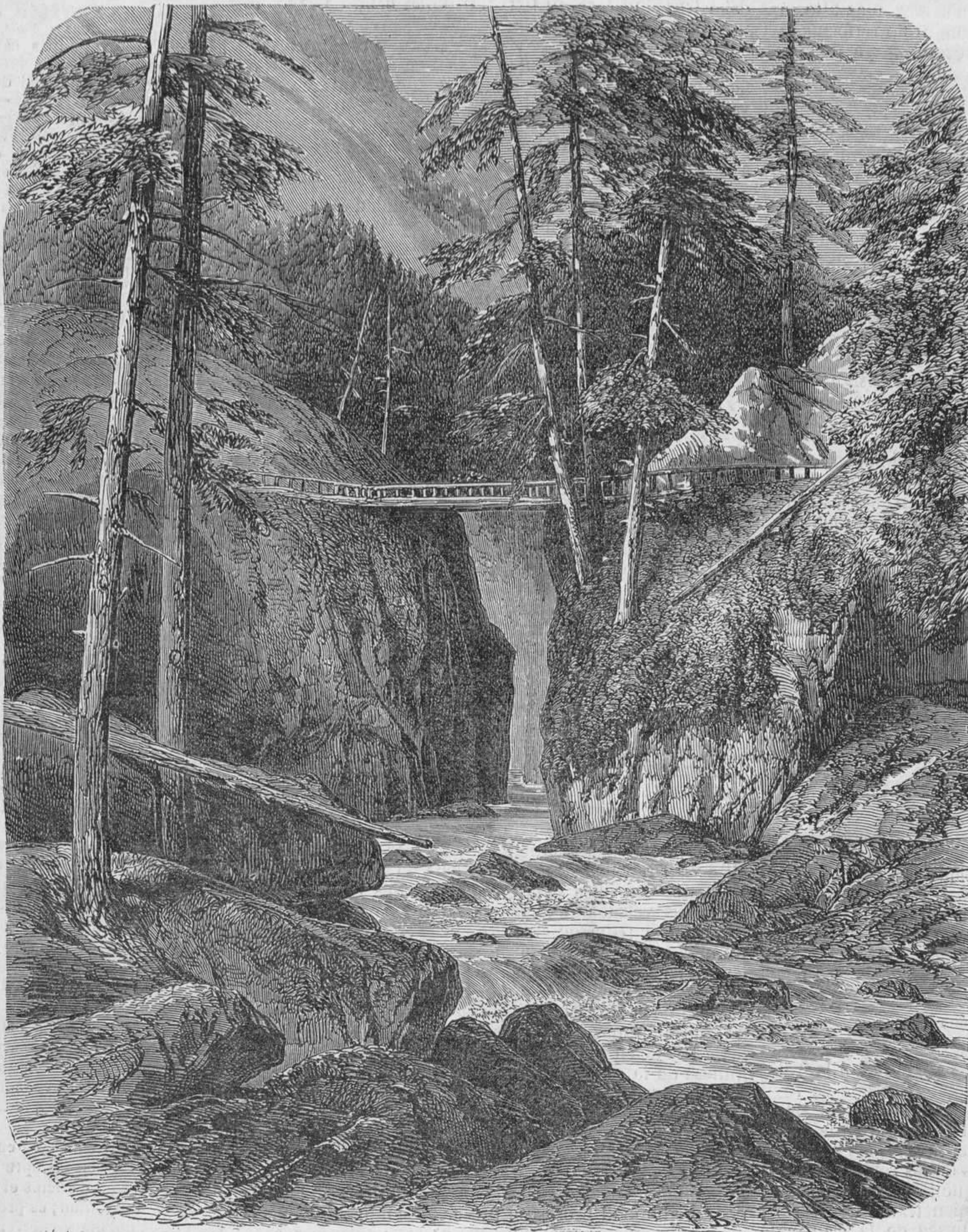
EL PUENTE DE ESPAÑA EN CAUTERETS.
