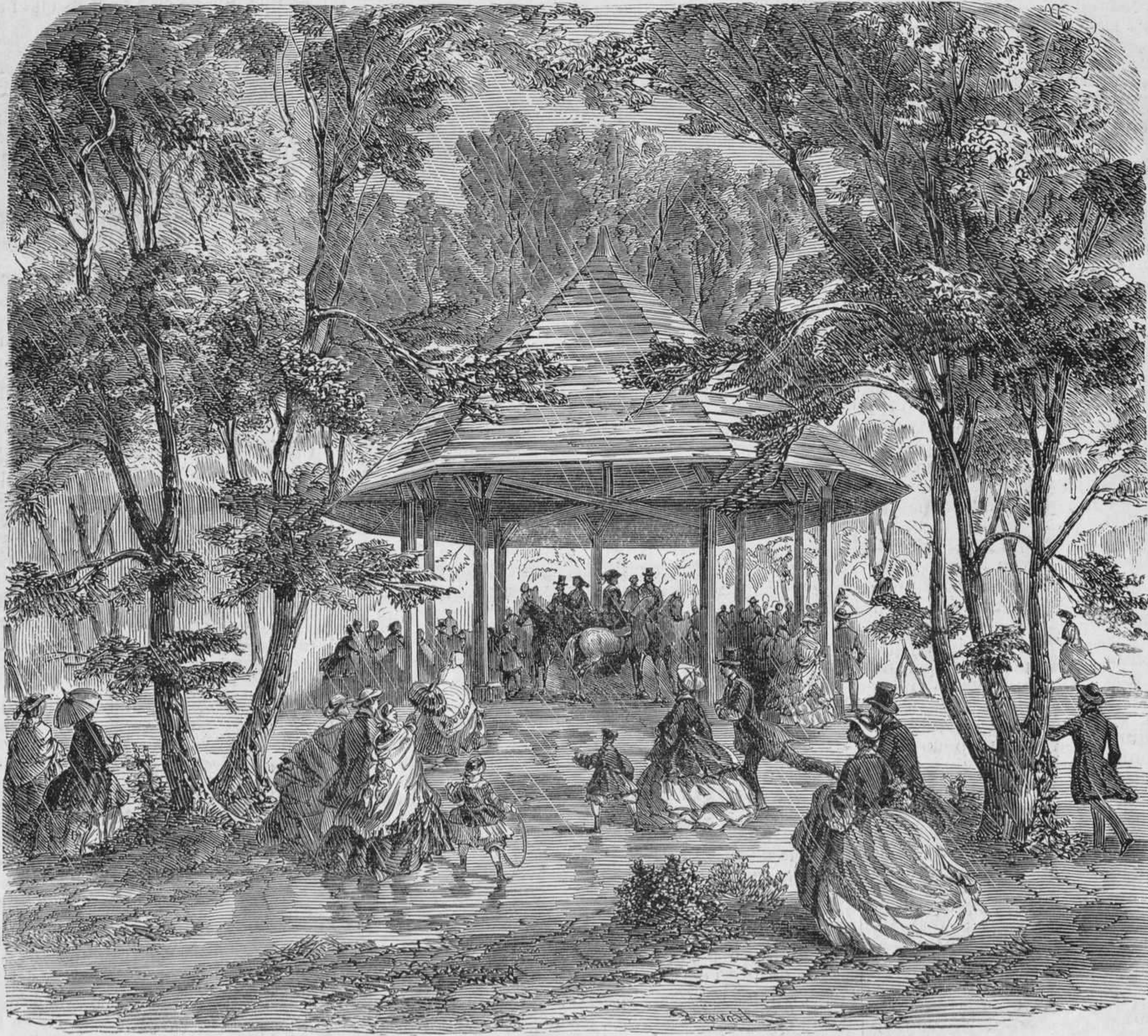
NUEVOS ABRIGOS CONSTRUIDOS EN EL BOSQUE DE BOULOGNE.
