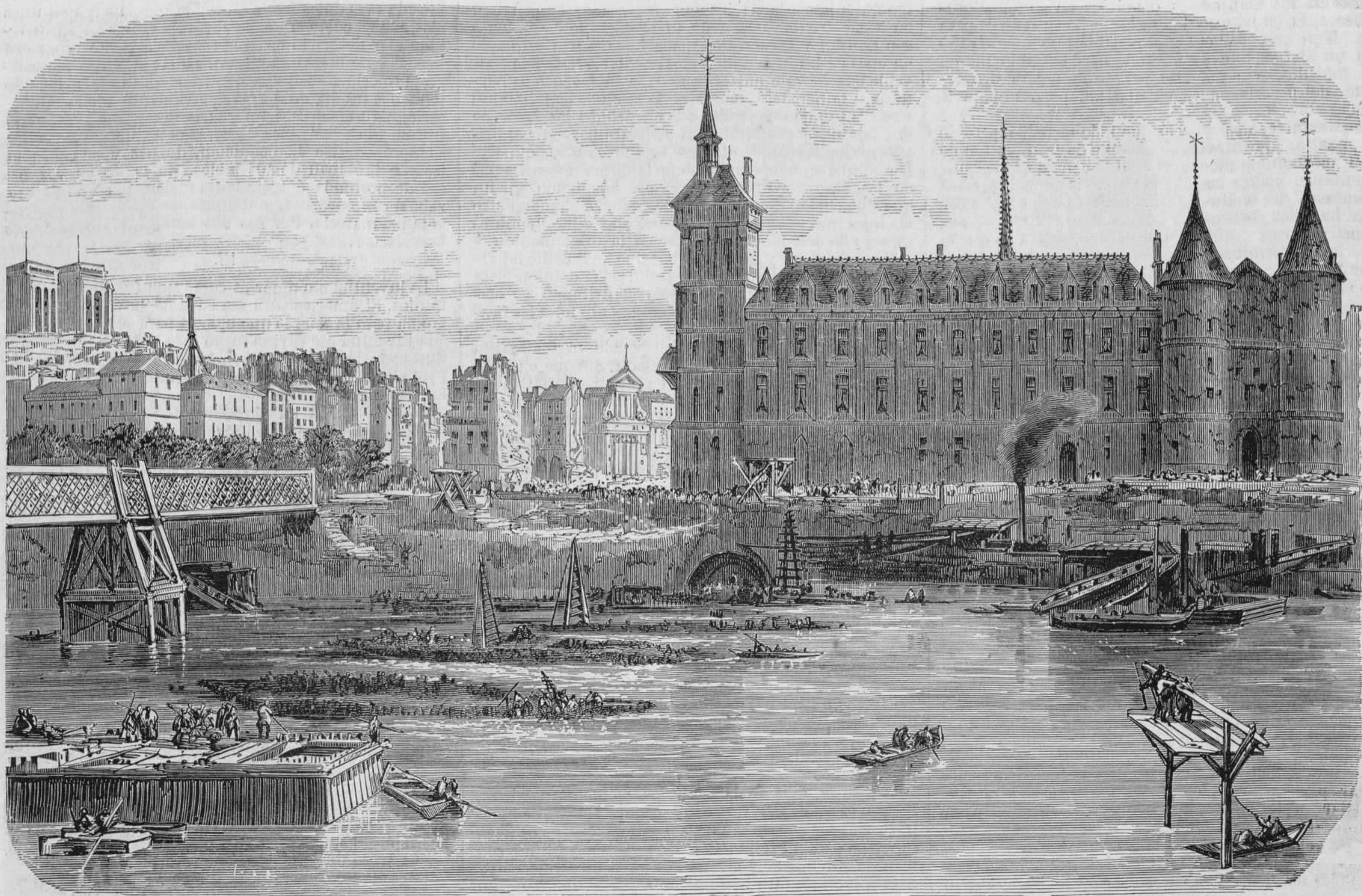
EMBELLECIMIENTOS DE PARIS —DEMOLICION DEL PUENTE DEL CHANGE Y DE LA CITÉ PARA LA CONTINUACION DEL BOULEVARD DE SEBASTOPOL.
