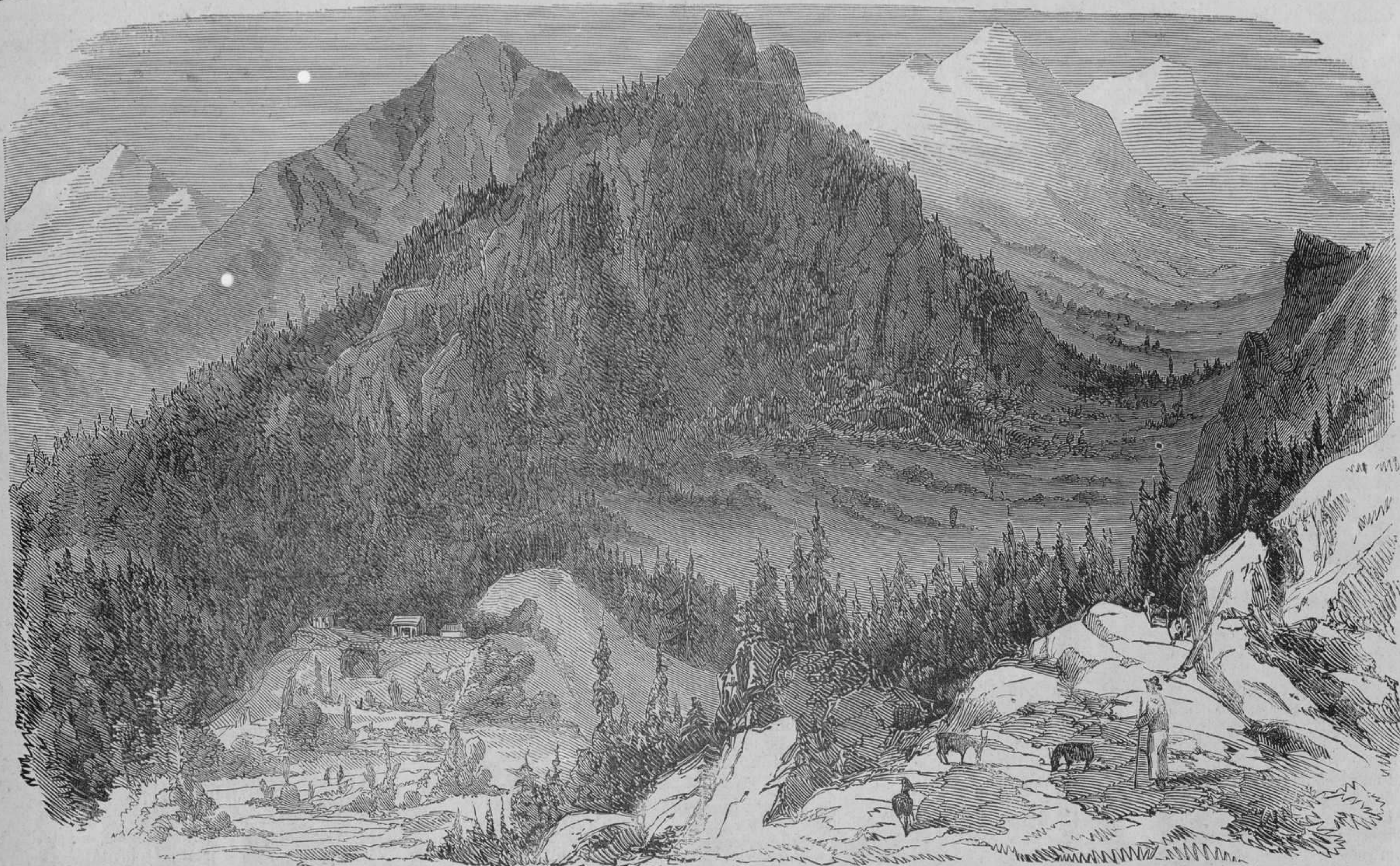
PERFORACION DEL MONTE CENIS. — INSTALACION DE LAS PRIMERAS OBRAS.
