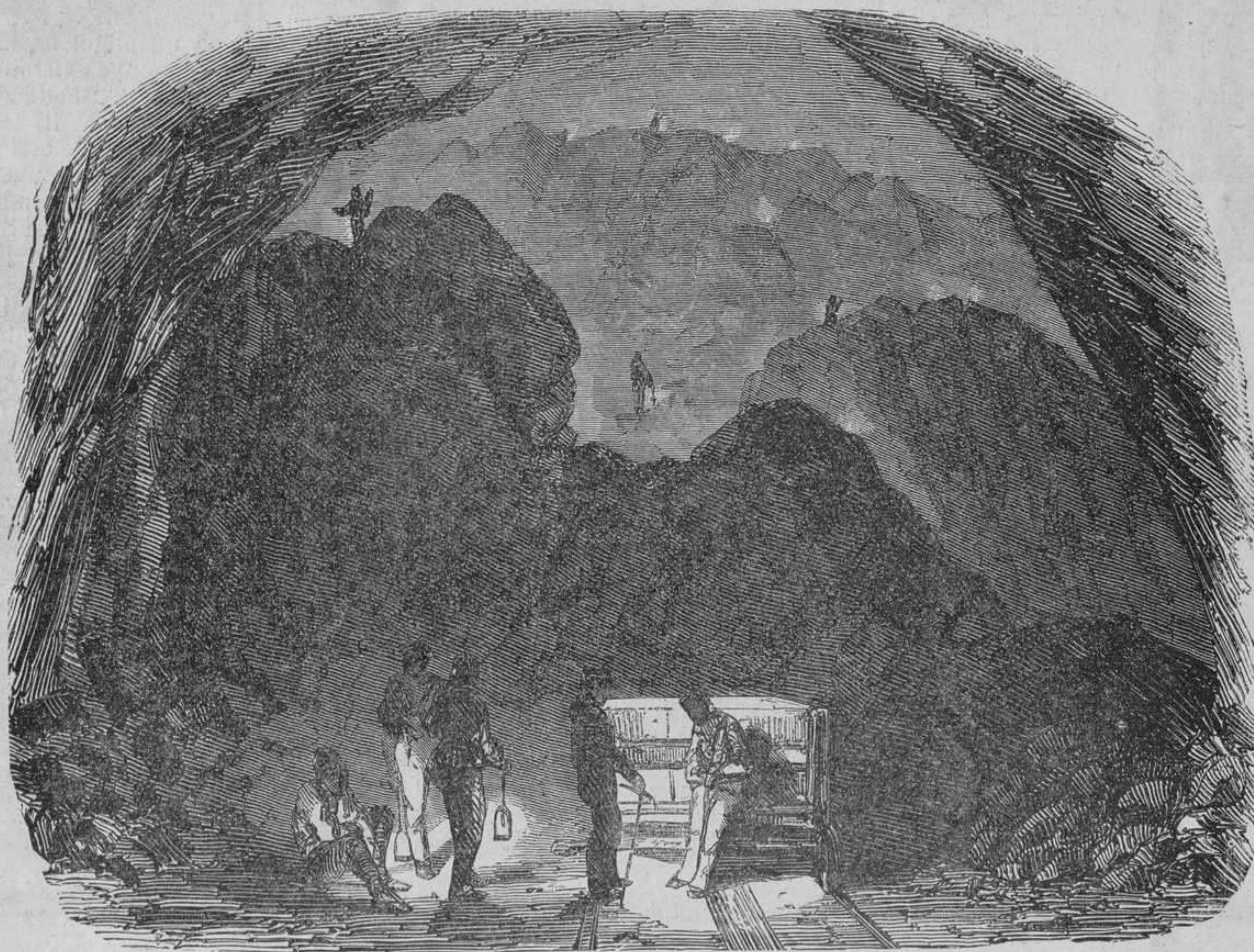
PRIMERAS OBRAS DE PERFORACION DEL TUNEL.
