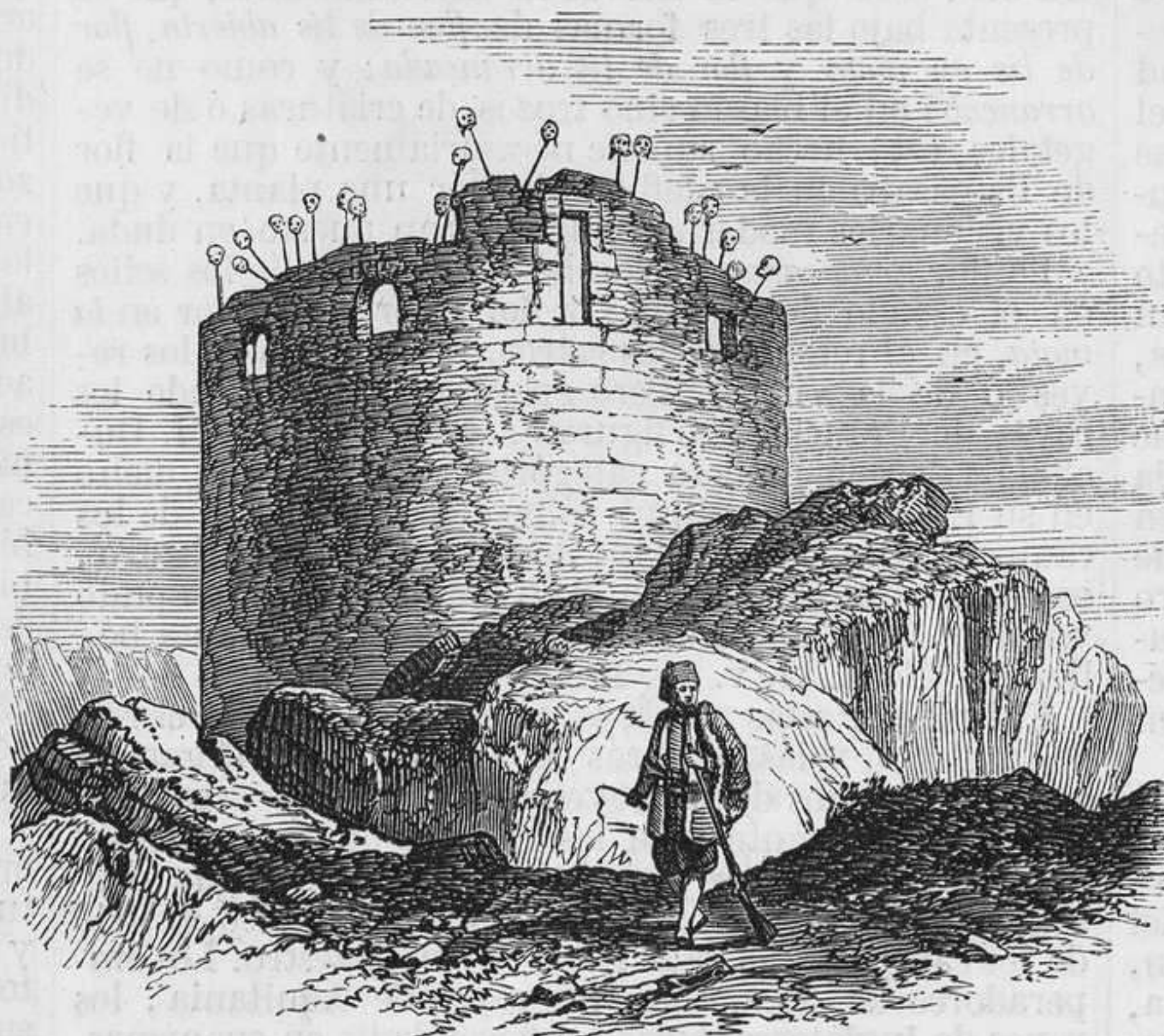
Torre de los Turcos, cerca de Cetiña.
