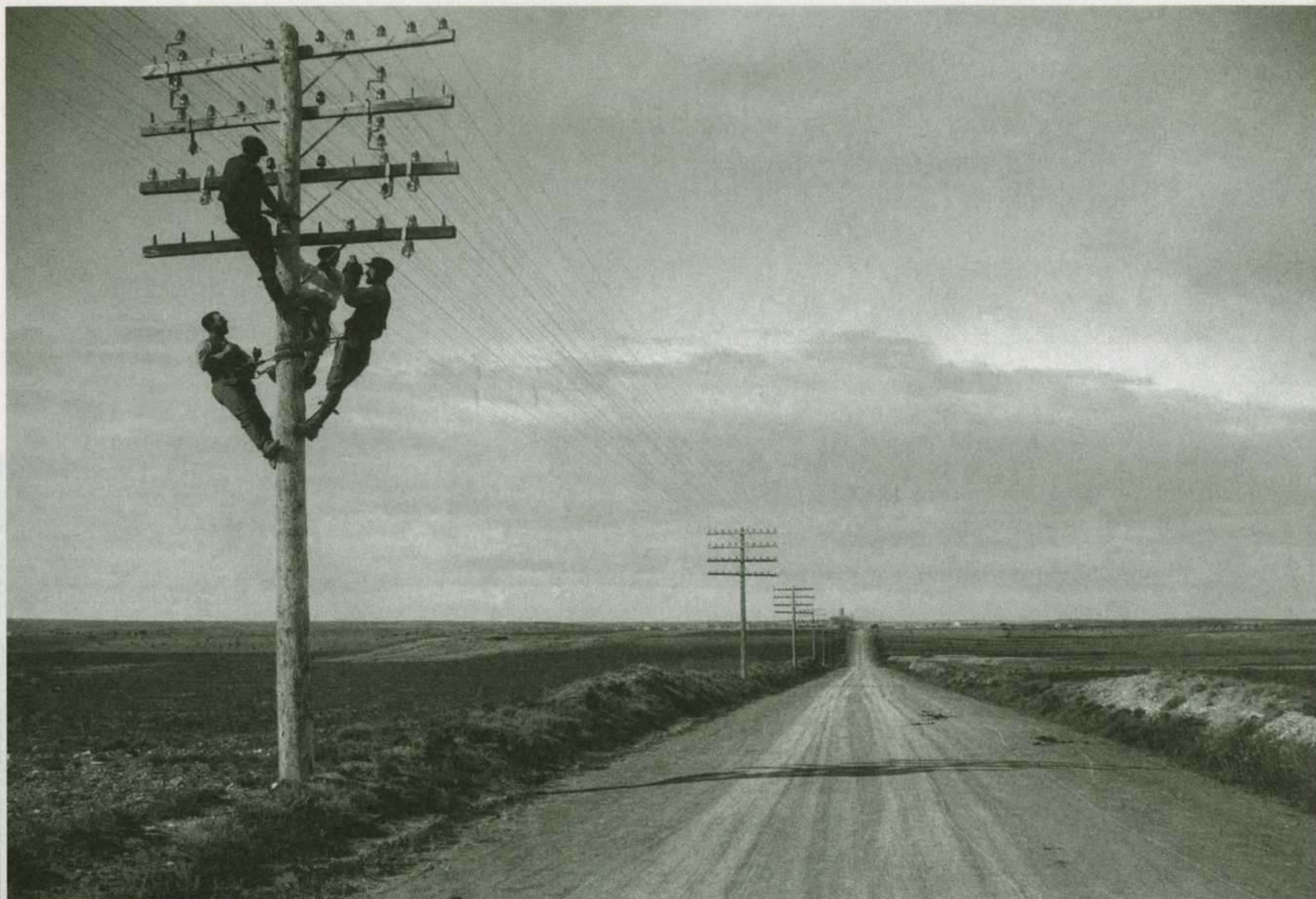
Línea telefónica Zaragoza-Barcelona, km 412 1928
