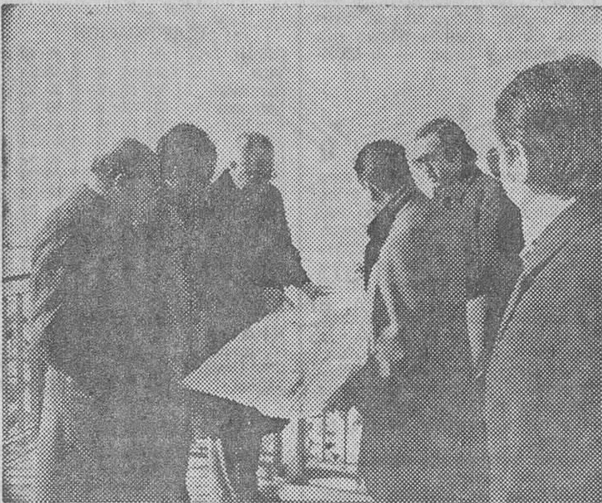
Una inspección de las obras, planos en mano.
