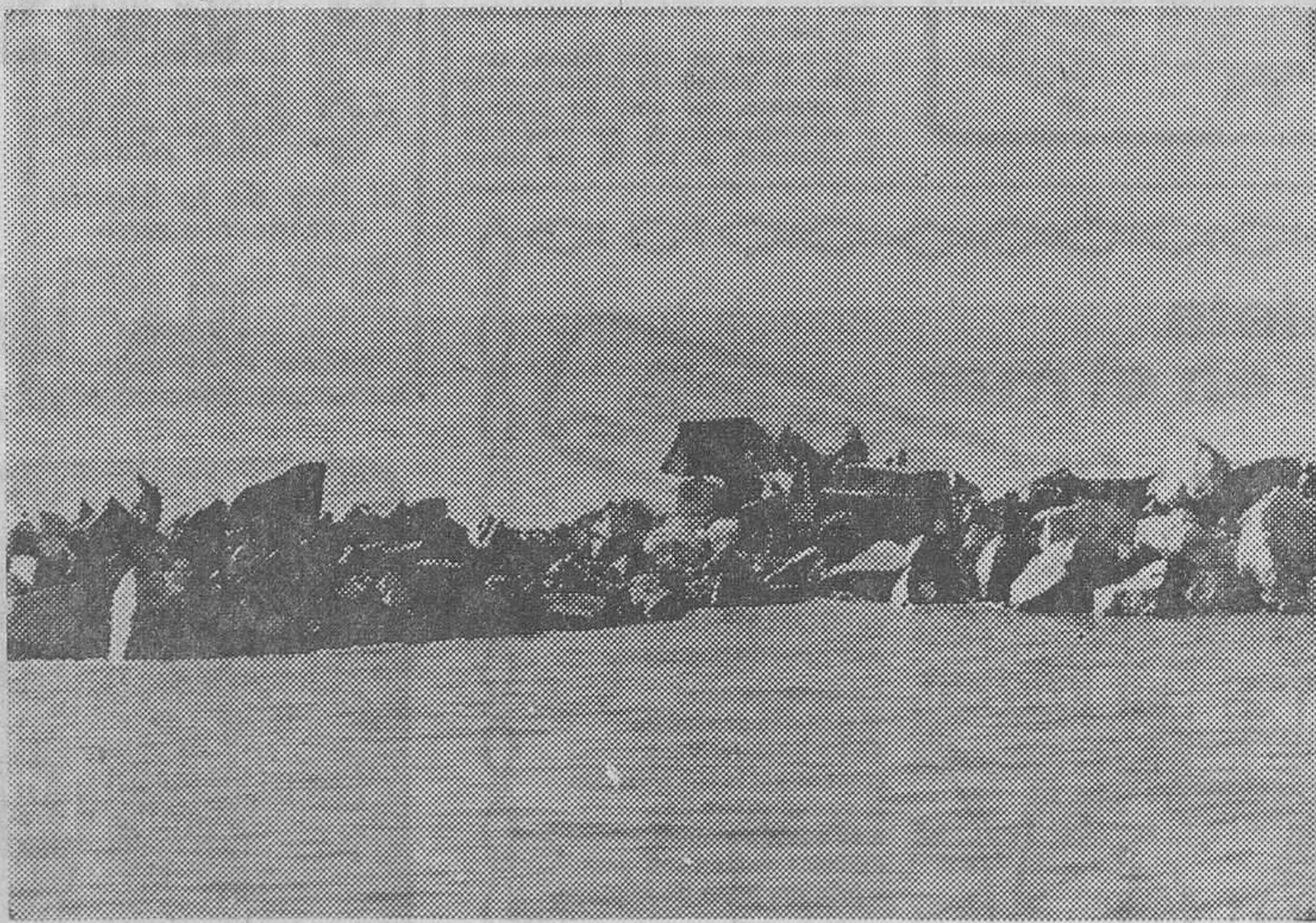
Vista parcial del dique Sur.
