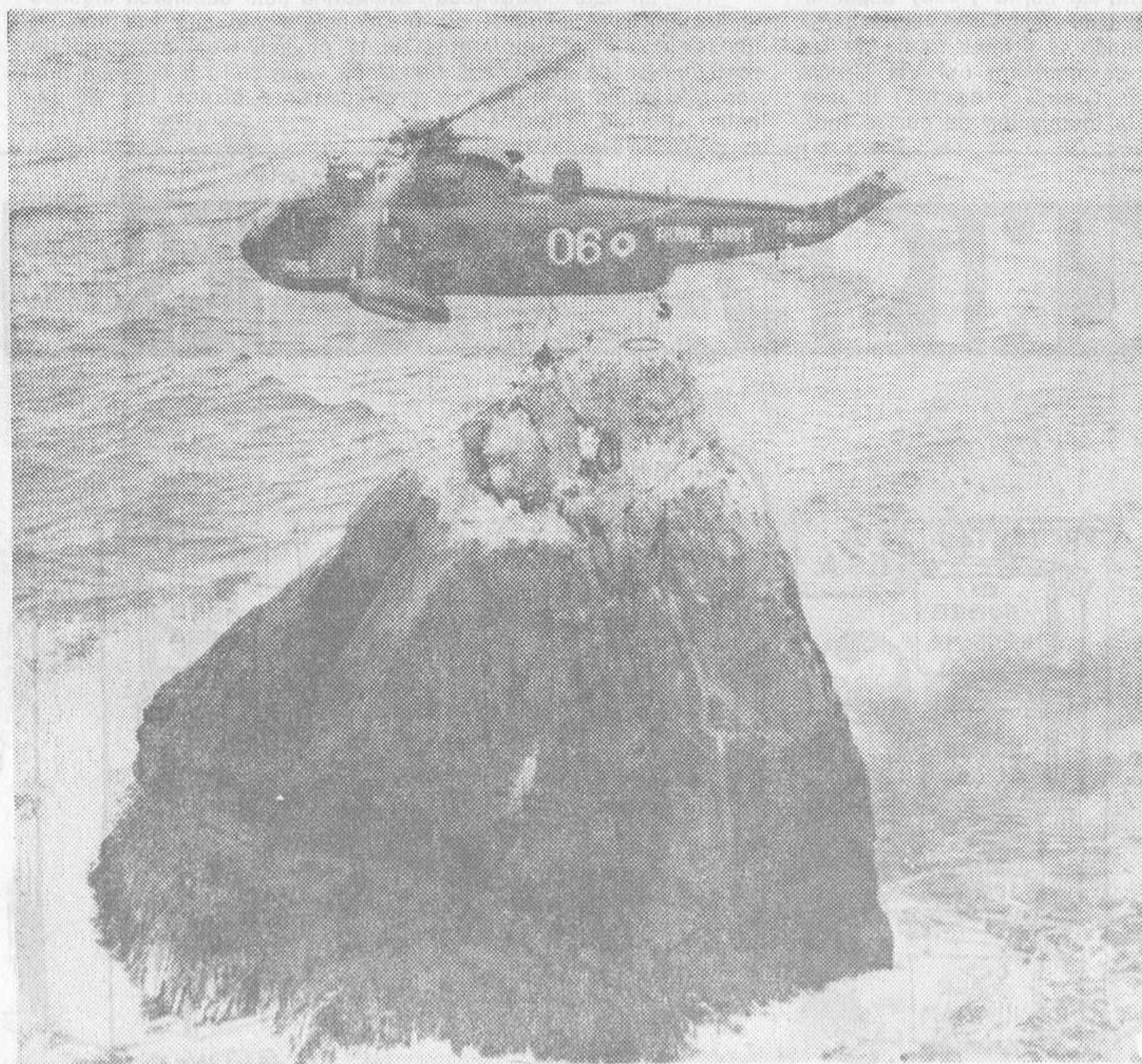
A pesar de los vientos huracanados, un grupo de trabajadores trasladados hasta este islote por un helicóptero de un barco de la armada británica, proceden a la instalación de un faro sobre esta peligrosa peña situada en el Atlántico, a unas 280 millas de la costa oeste de Escocia. El faro, de bronce y fibra de vidrio, funcionará automáticamente durante un año sin necesidad de ningún tipo de atención. — (Foto Upi-Cifra)
