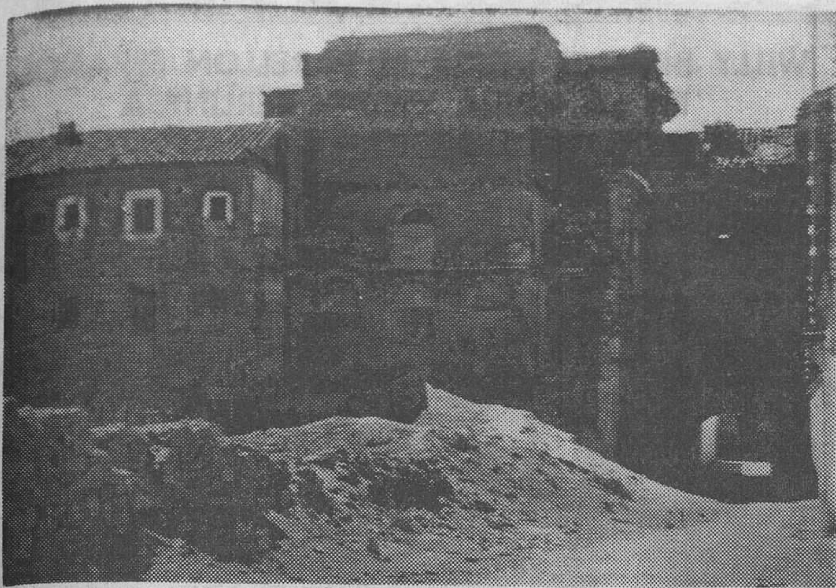
La Solana. — Vista del histórico convento de Trinitarios, abandonado por éstos en 1836 con motivo de la desamortización de los bienes de las comunidades religiosas. Ahora se derriba parcialmente para construir un grupo escolar. La parte afectada por la piqueta corresponde a las celdas de novicios, que habitó San Miguel de los Santos. Dicho convento fue fundado en 1604 por el beato Juan Bautista de la Concepción, reformador de la Orden Descalza Trinitaria (Foto Cifra)
