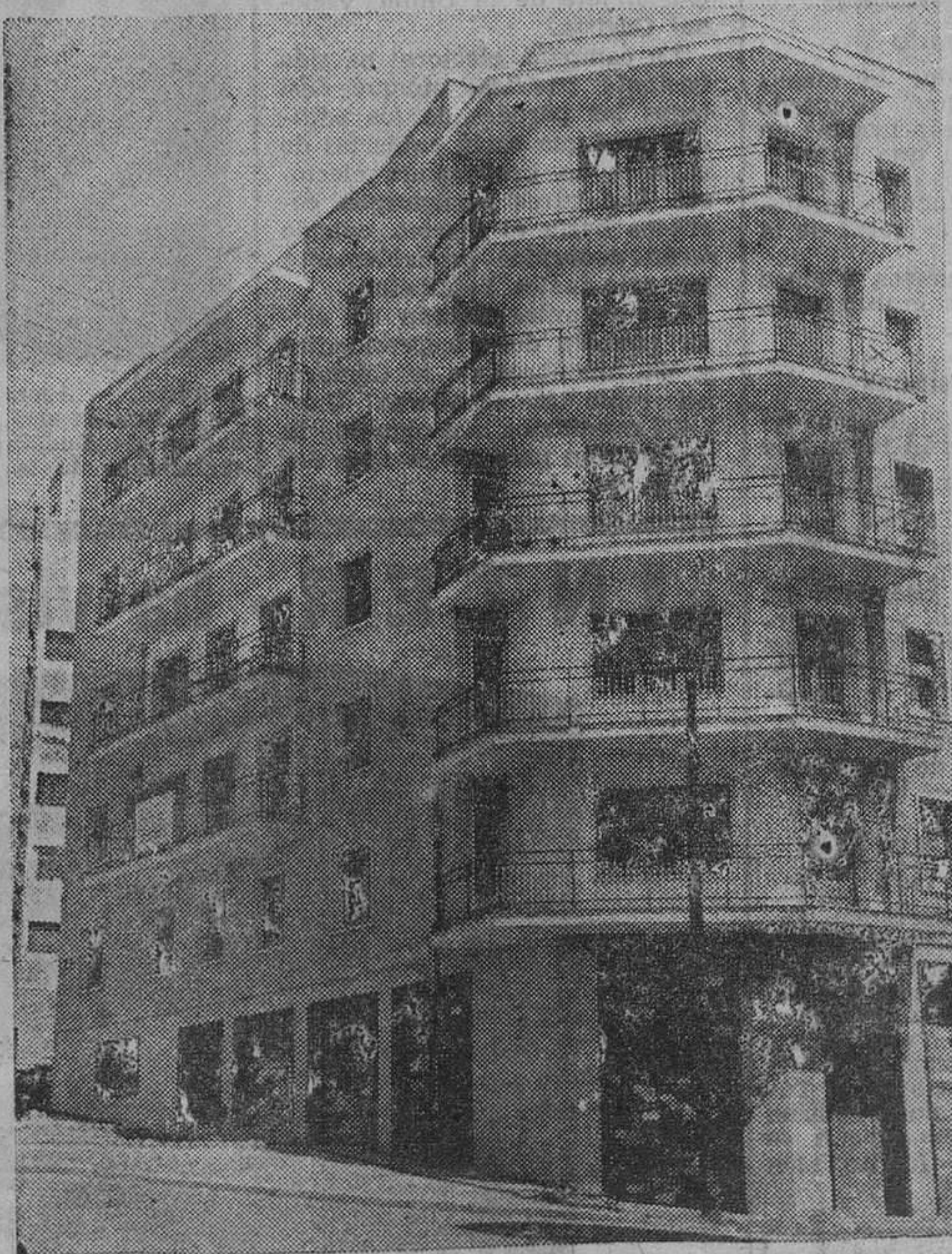
Uno de los varios grupos de viviendas, de líneas modernas y estilo propio, construidas y entregadas por SAICA
