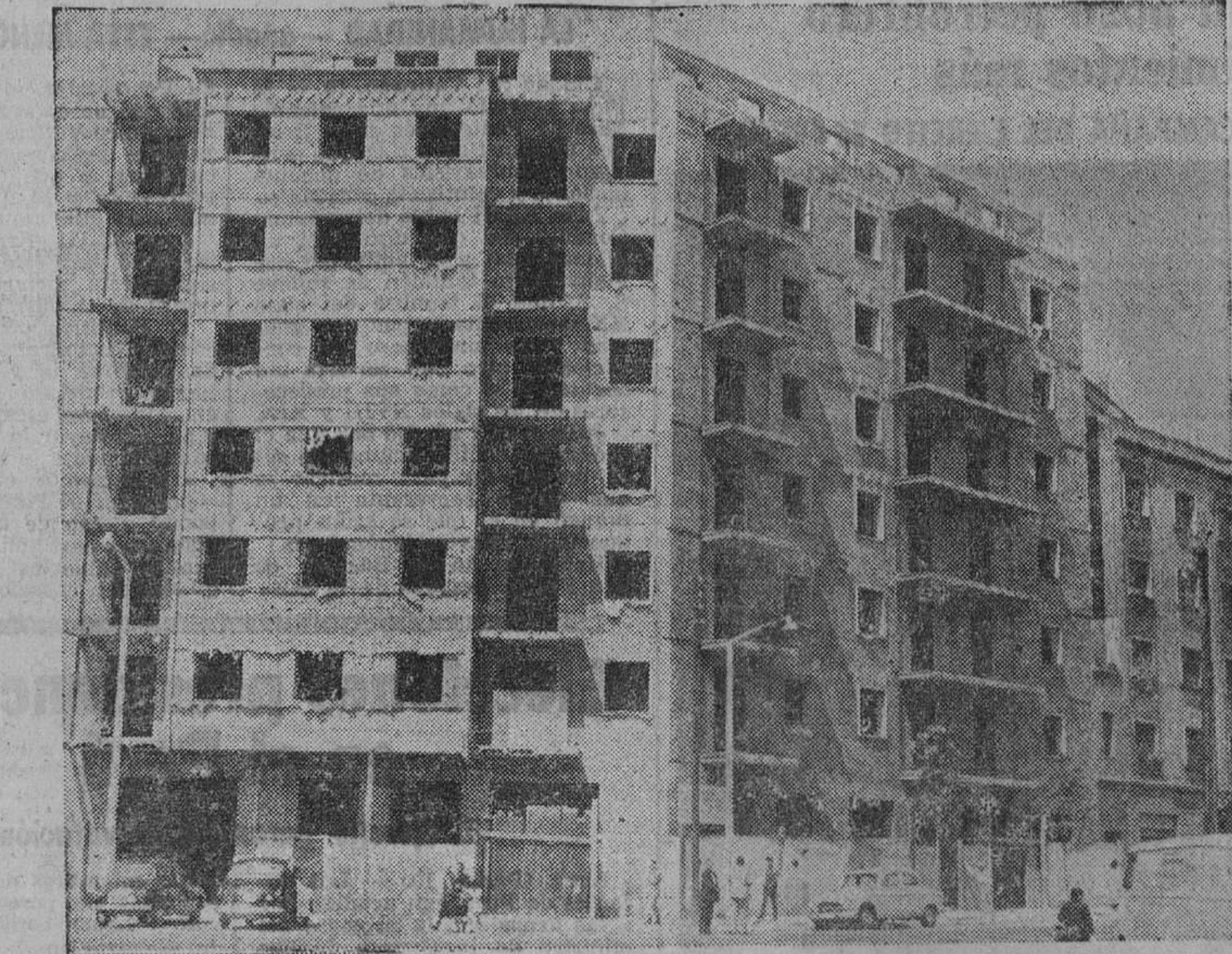
Grupo de viviendas de próxima terminación construidas por SAICA, Sociedad Anónima Inmobiliaria Cataluña, arquitecto don Juan Maresma Gimeno
