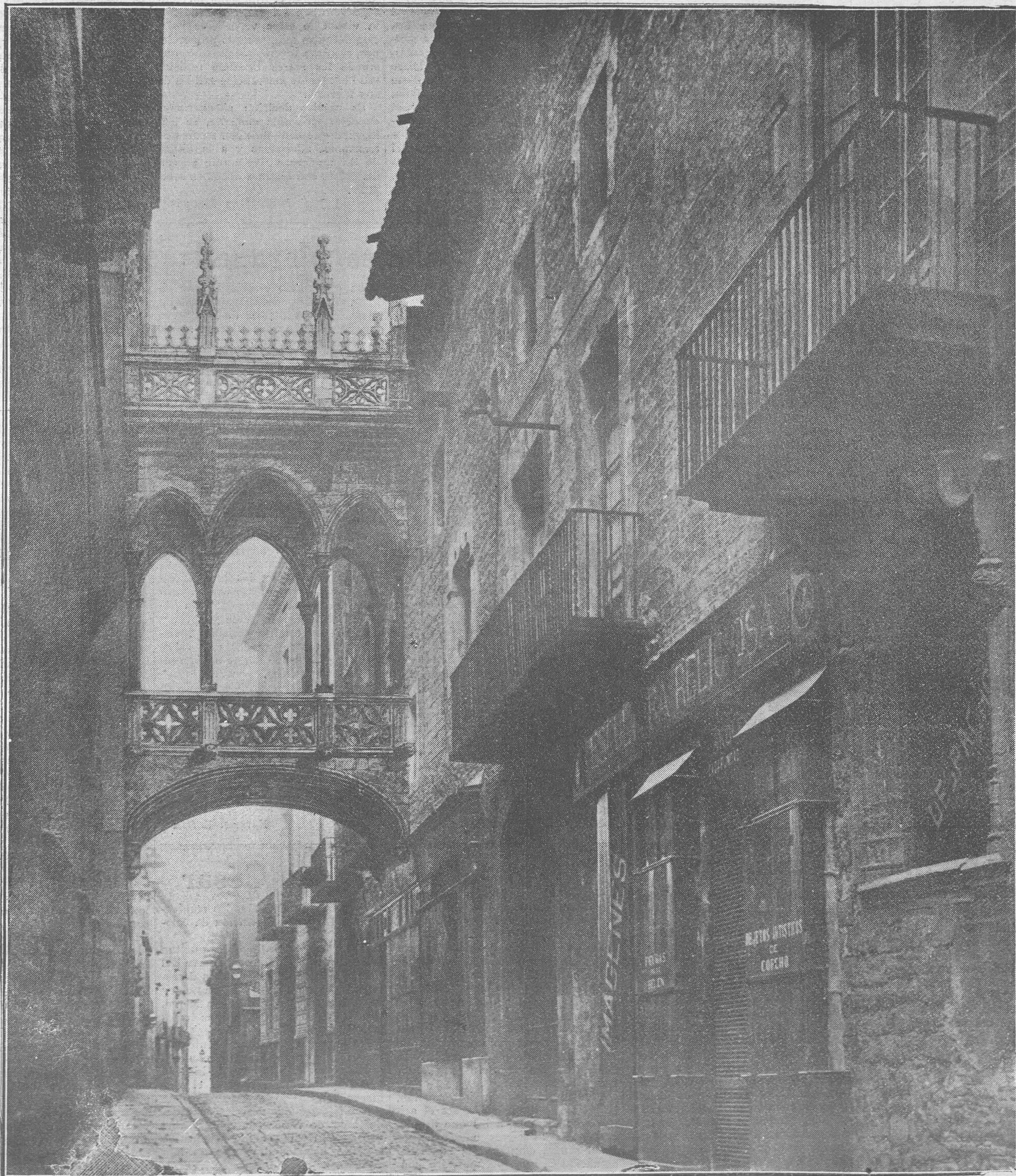
Puente gótico de tres arcos, en construcción, proyectado por el arquitecto Director de los Servicios provinciales, D. Juan Rubió y Bellver, para unir el Palacio de la Diputación con el edificio adquirido por la misma, en la calle del Obispo, para ampliación de las dependencias provinciales,
