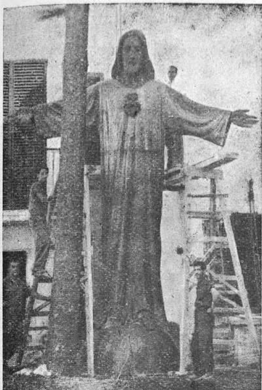
CONSTRUCCIÓN DE LA ESTATUA EN EL PALACIO EPISCOPAL.
