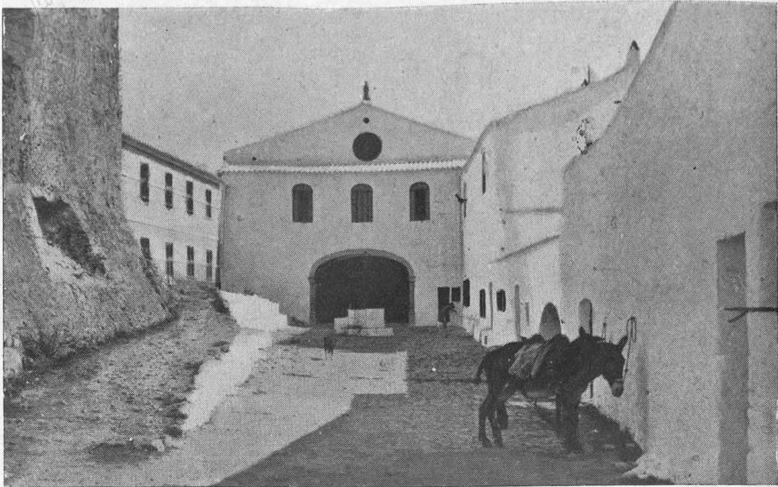
PATIO ANTES DE LA REFORMA.
