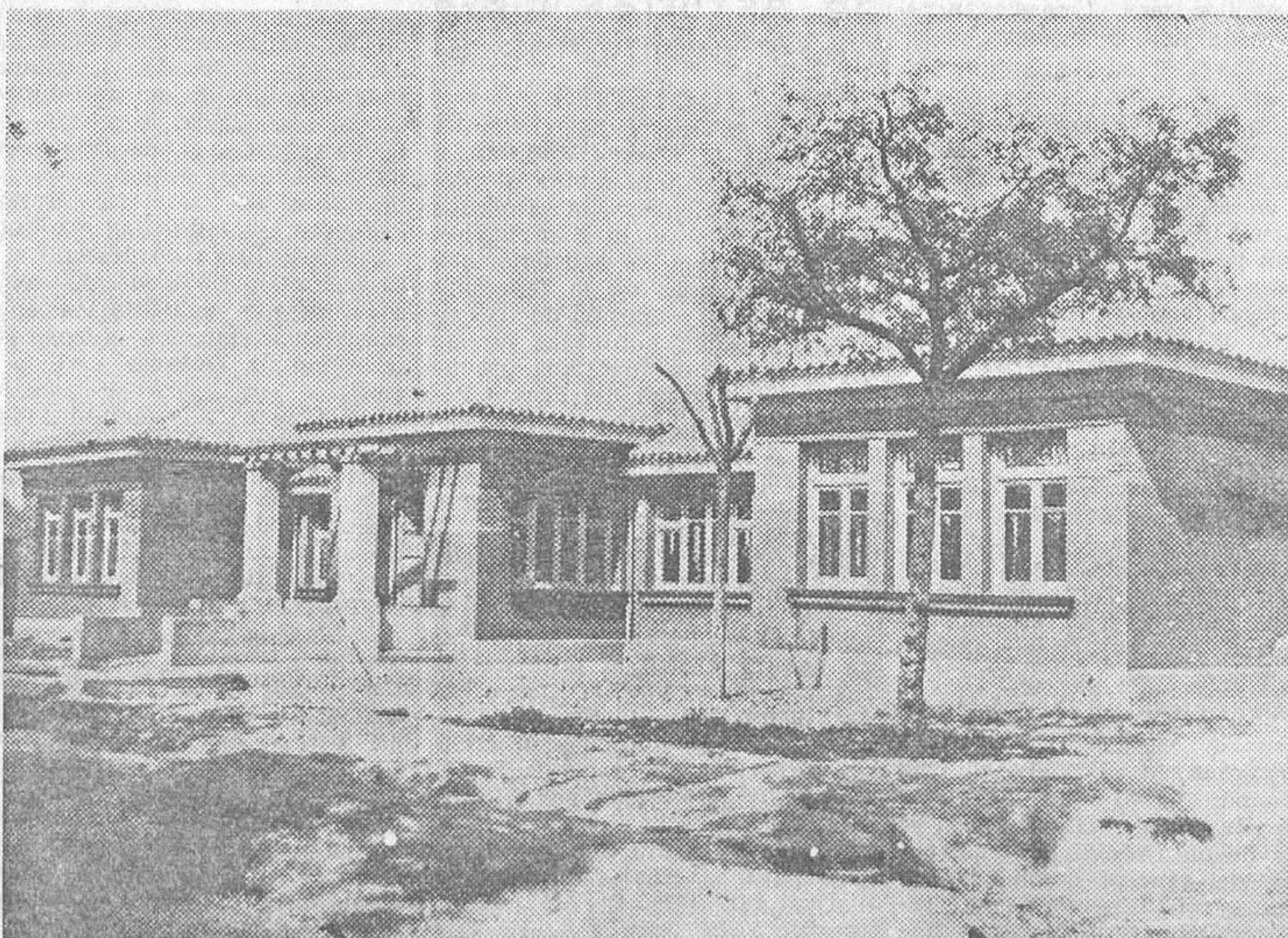
GETAFE.—Grupo escolar recientemente construido y que va a ser inaugurado en breve (Fot. Eizyero.)
