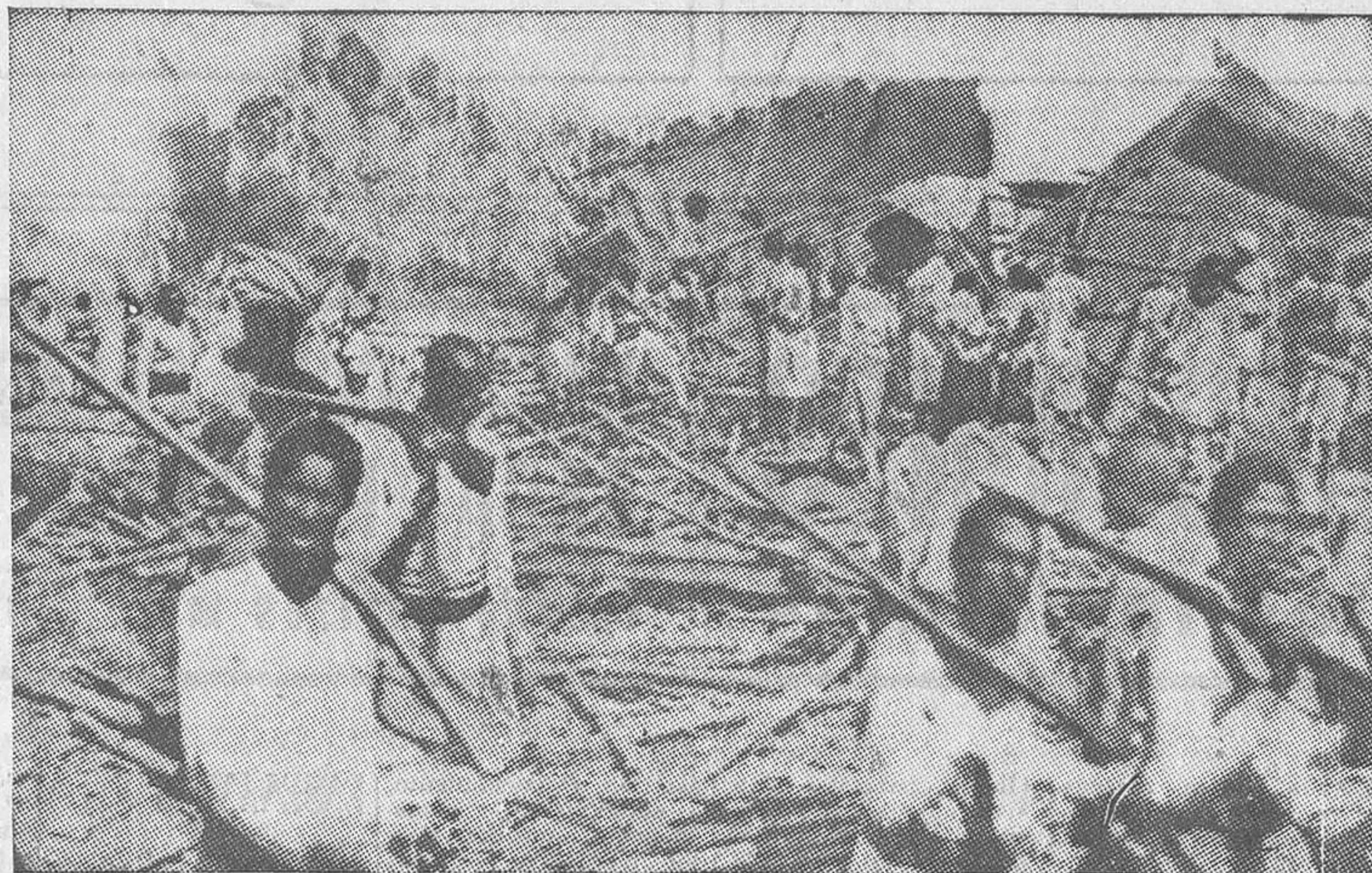
El aspecto desolador que ofrece la ciudad de Dessie después del «civilizador» bombardeo de los aviones fascistas
