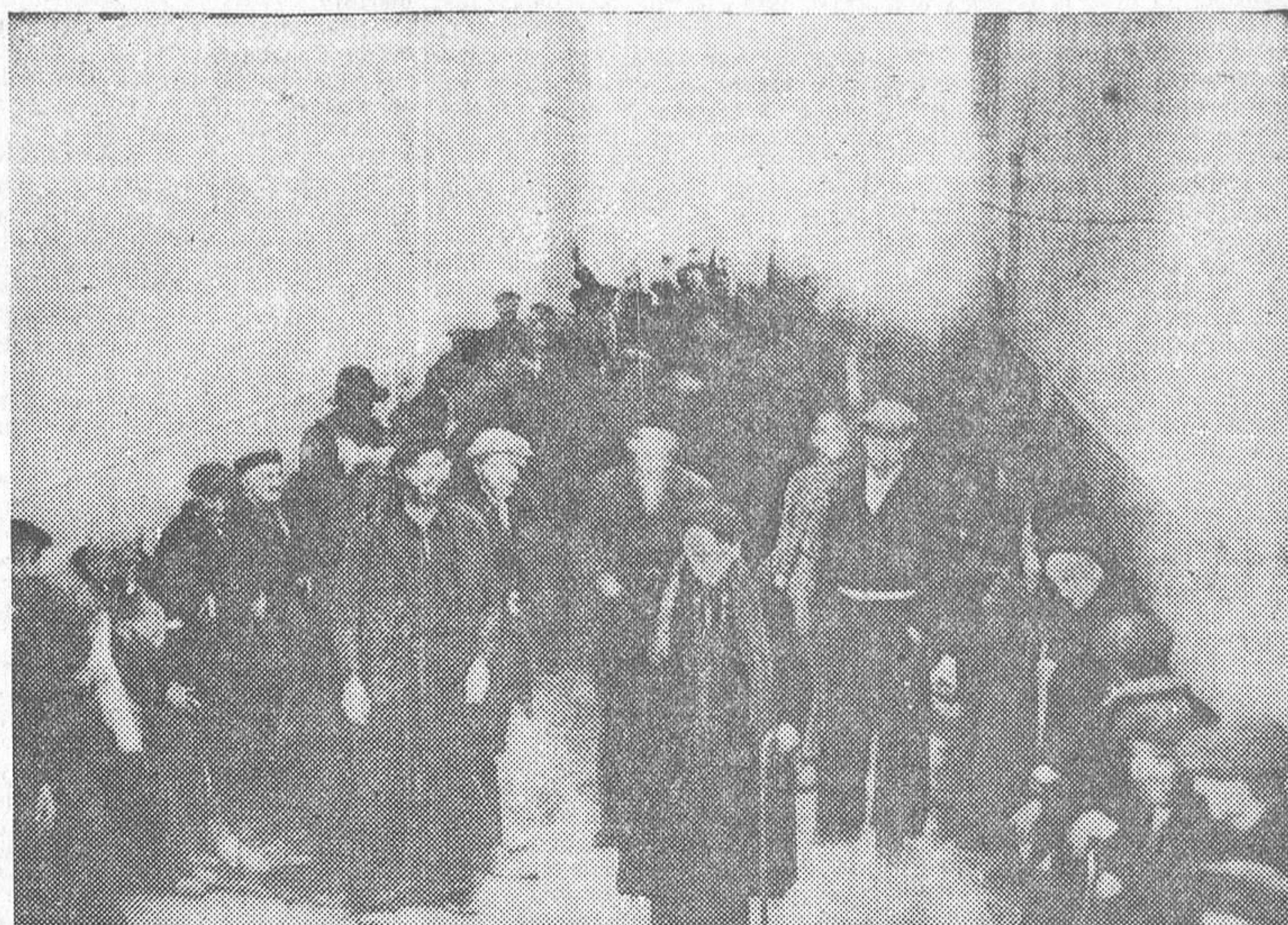
En el Parque de Asistencia de la calle de Riego, los mendigos recogidos están en esta galería, oscura y sucia, donde, como apenas existen bancos, han de permanecer unos encima de otros horas y horas...
