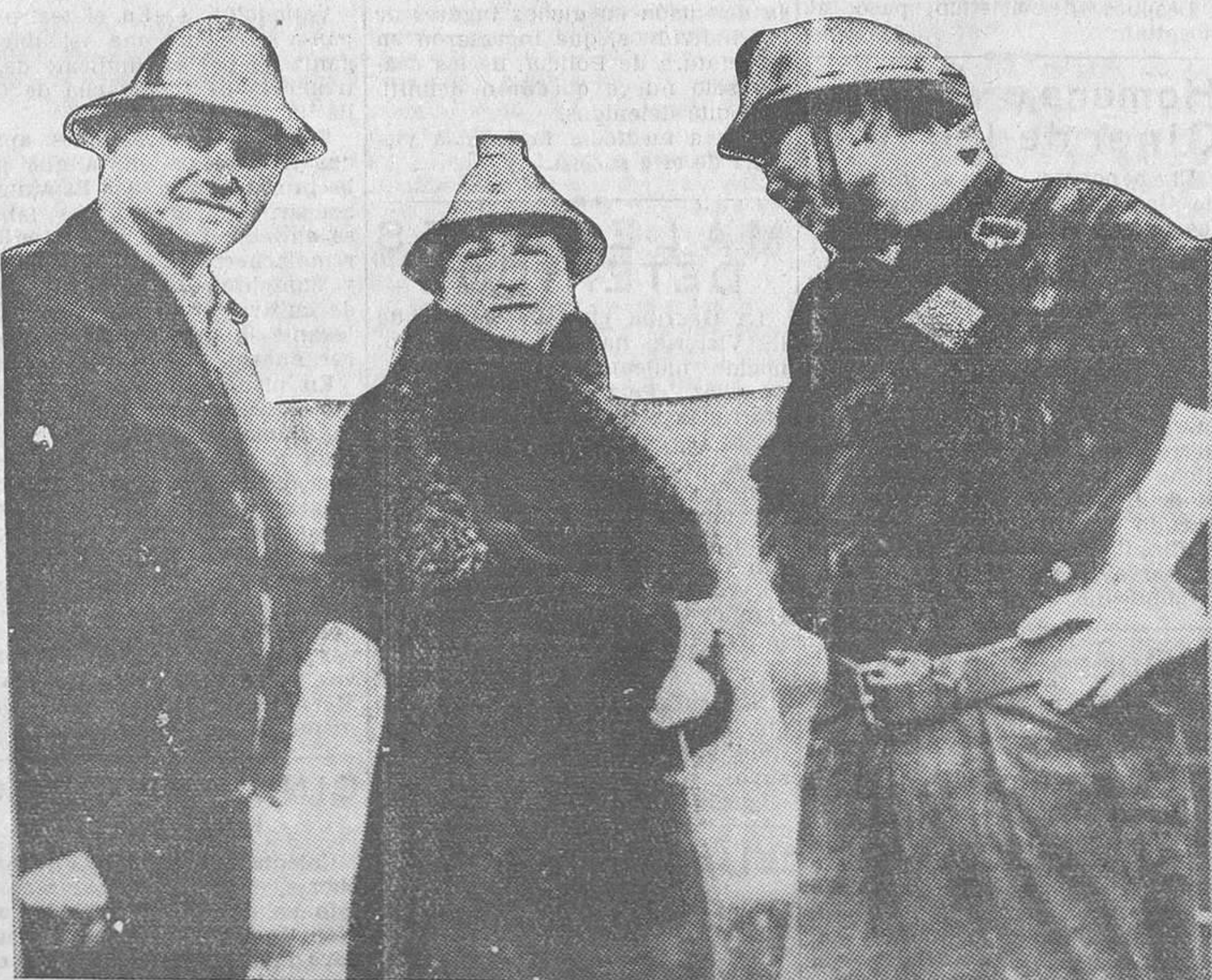
UN CASCO PARA LOS OBREROS.—La señorita Francis Perkins, subsecretaria del ministerio de Trabajo de los Estados Unidos, ha dotado a los obreros que trabajan en la construcción del puente de la Puerta Dorada, en San Francisco, de un casco de cuero, destinado a protegerlos de eventuales caídas de materiales.
