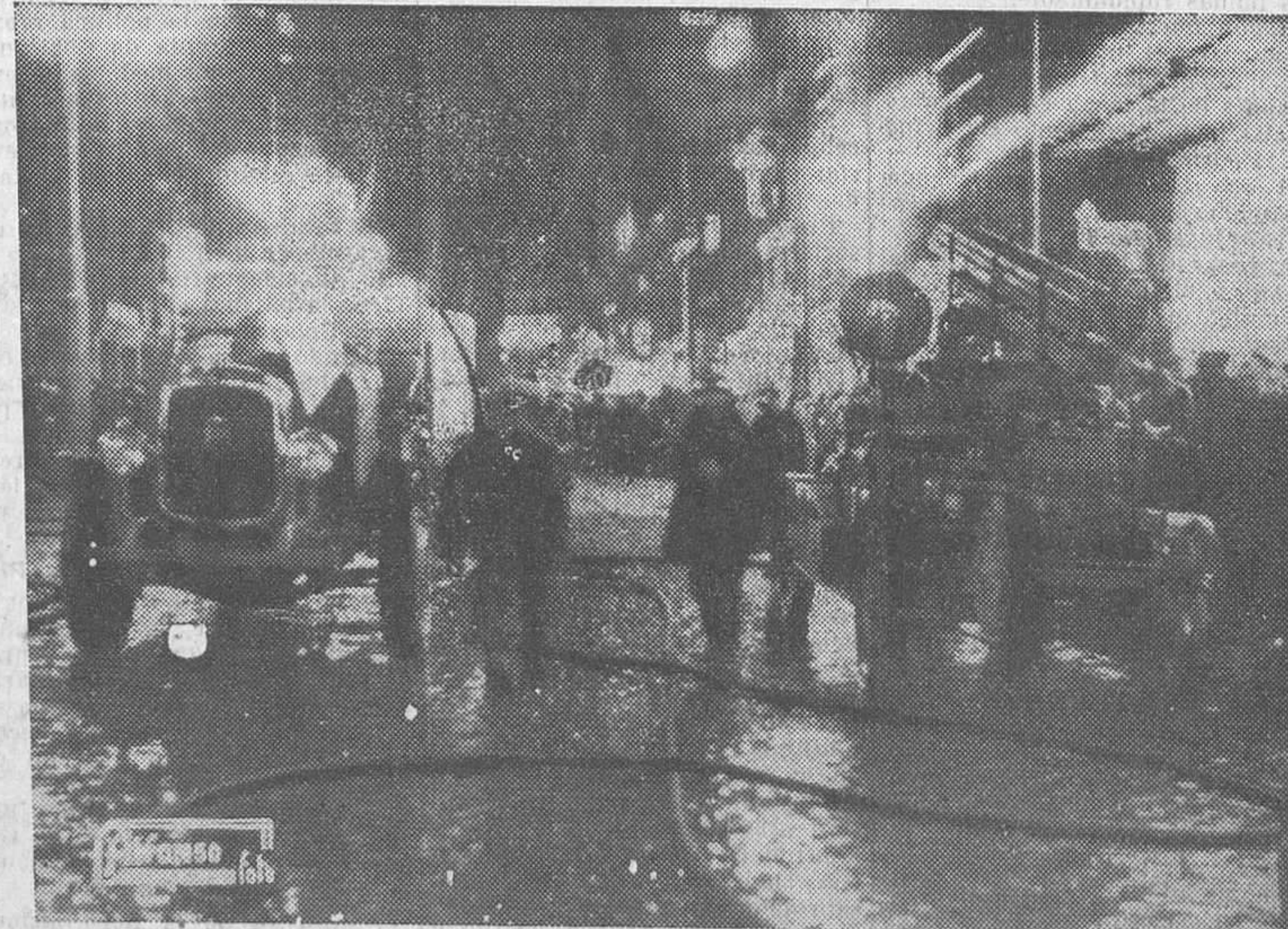
Fantástico aspecto que ofrecía anoche la avenida de Pi y Margall durante los trabajos de los bomberos en la extinción del fuego de la casa número 17, esquina a Callao (Instantánea de noche por Alfonso.)
