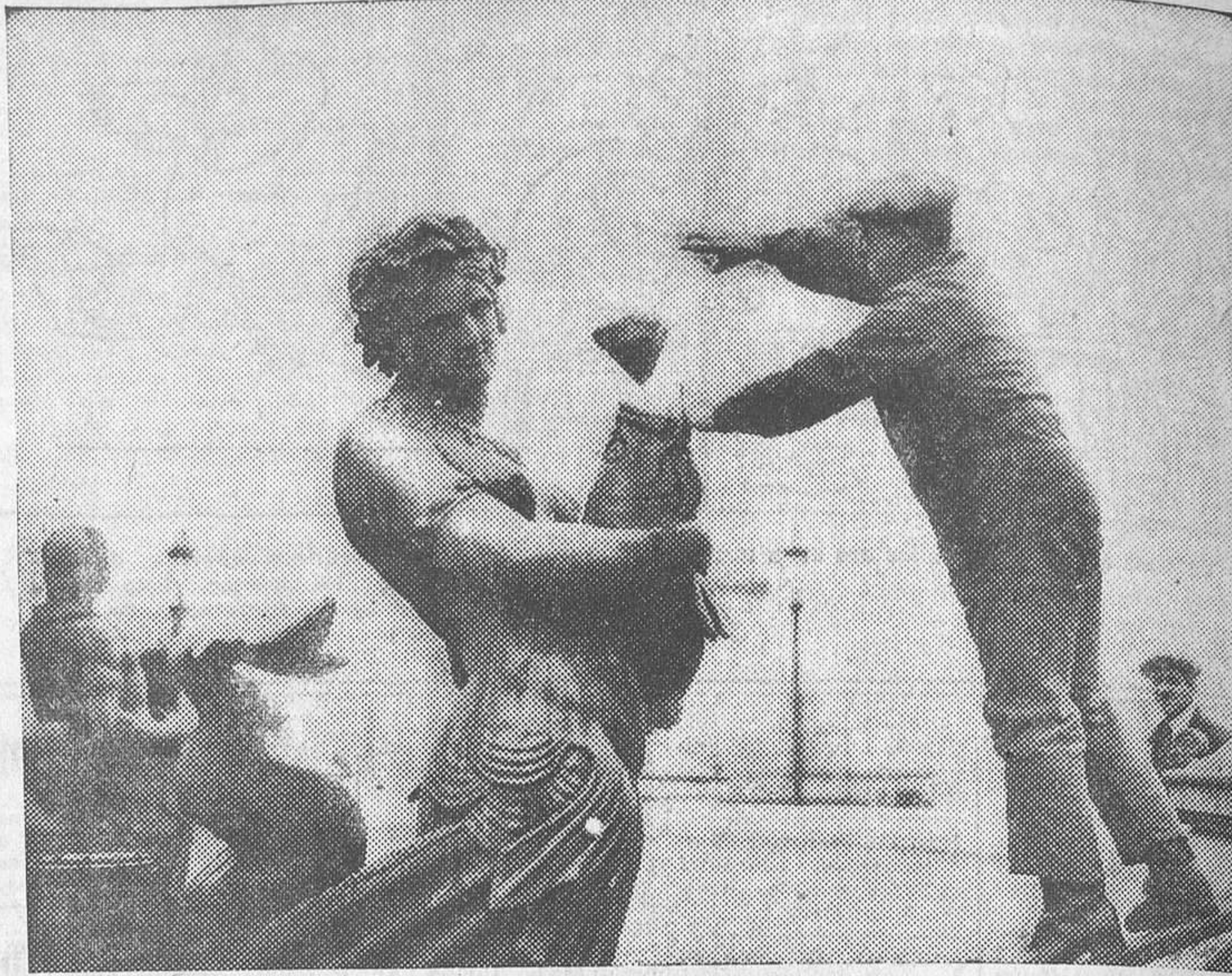
Con la ayuda del ácido clorídrico, las stenas de las fuentes de la plaza de la Concordia, de Paris, hacen su «toilette». Obreros especializados se ocupan de estos «soins de beauté» (Fot. Ortis-Keystone.)
