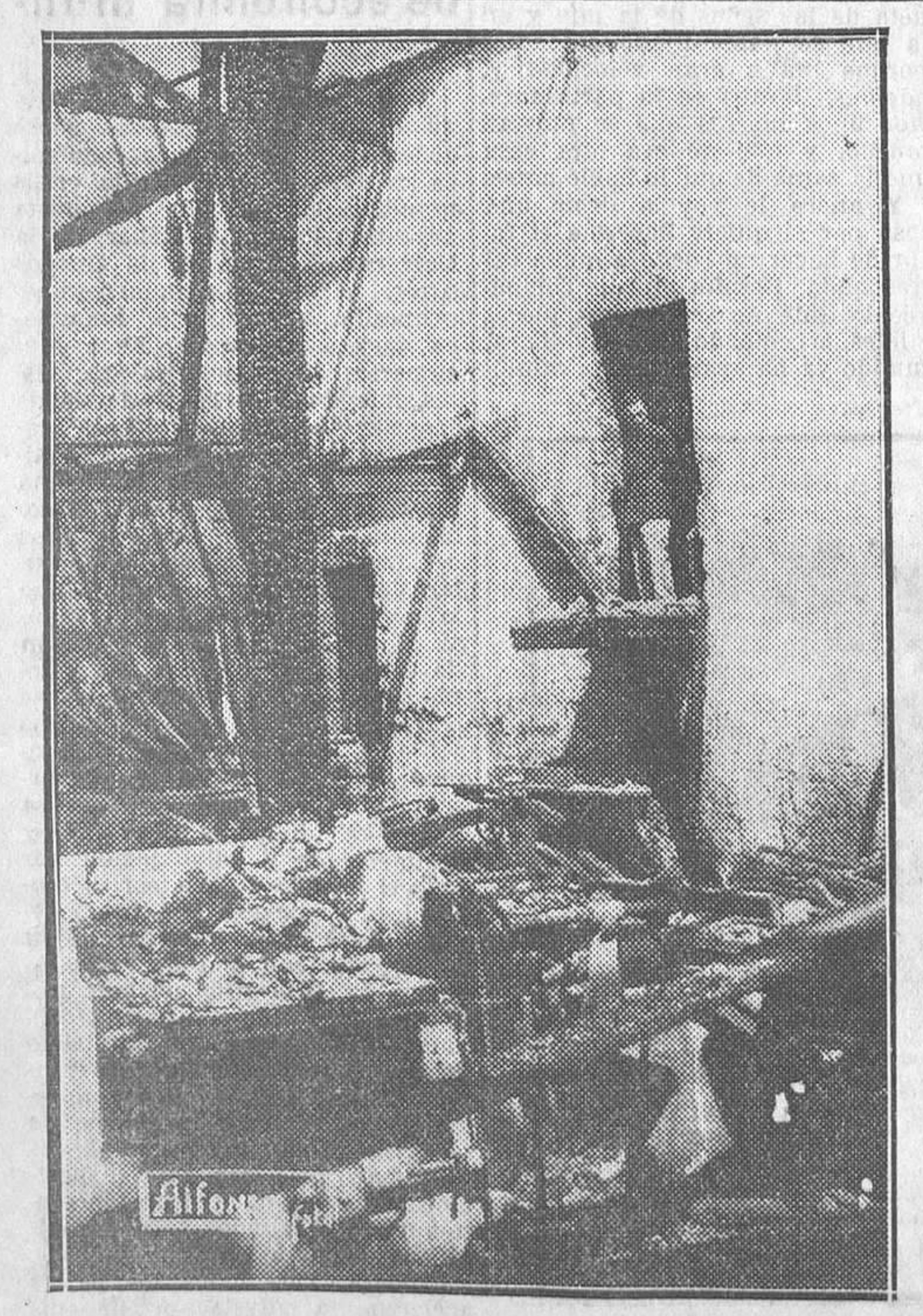
Estado en que ha quedado el taller de carpintería y almacén de madera de la calle de Vargas, después del incendio de la madrugada de ayer (Fot. Alfonso.)
